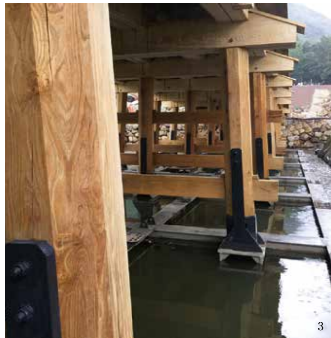
1. 擬宝珠橋の3次元図 2. 発掘調査時に確認された橋脚の遺構 3. 木橋と水中梁の接合部
