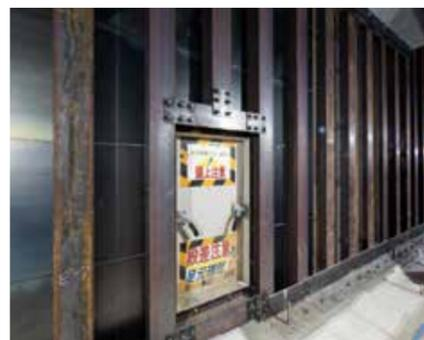
新たに組まれた躯体の鉄筋や、止水のために組み上げられた仮設の鋼製遮水壁。デジタルがどれだけ発達しても、こうした手作業で行われる部分なくなることはない。
