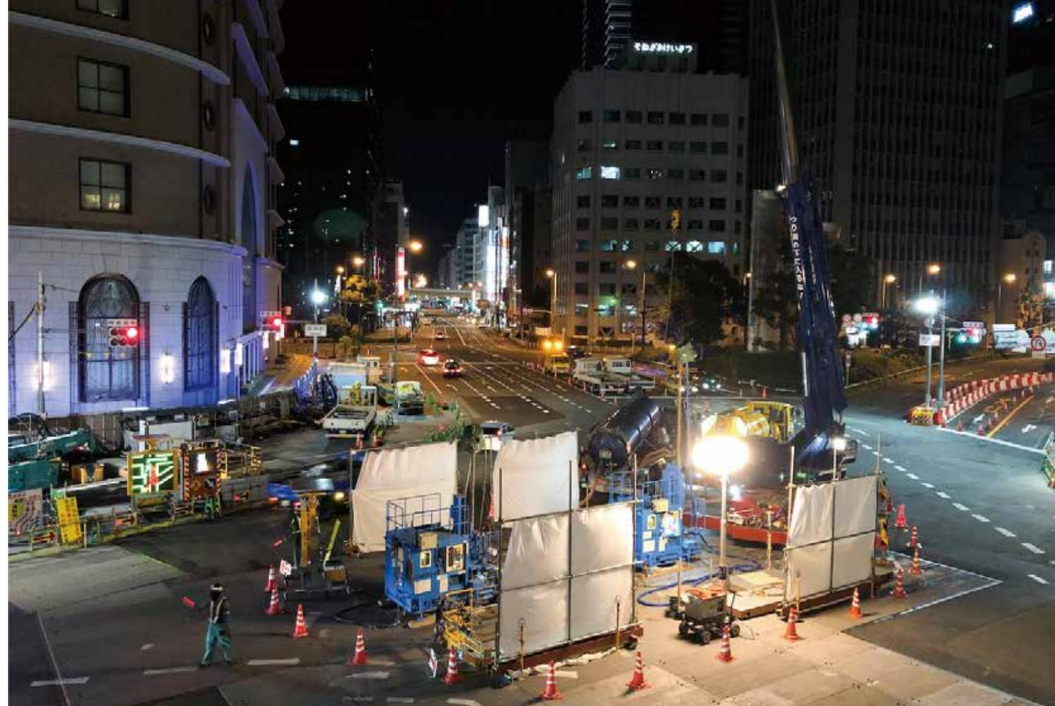
夜間、道路規制をしながらの開削作業。複雑な工程の管理には、作業手順を“可視化”する4次元シミュレーションシステムを活用している。(画像提供：株奥村組)
