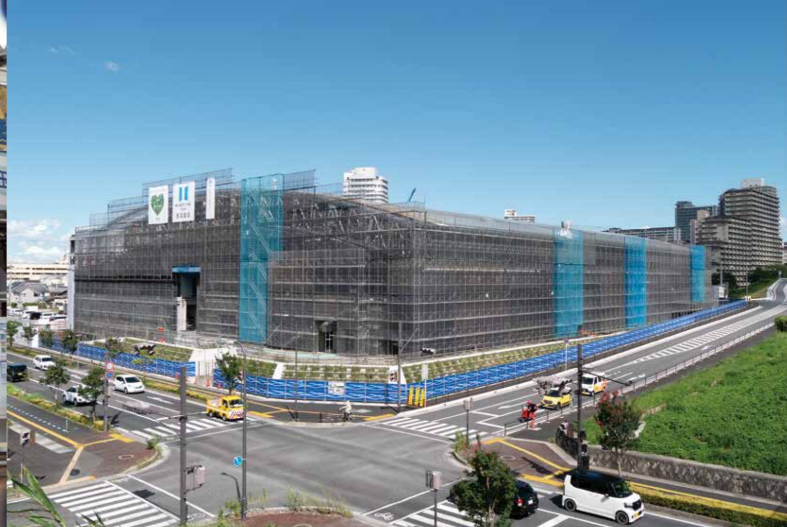
旧草津川沿いの土手の上から見た(仮称)草津市立プール。敷地いっぱいに建てられていることがわかる。
