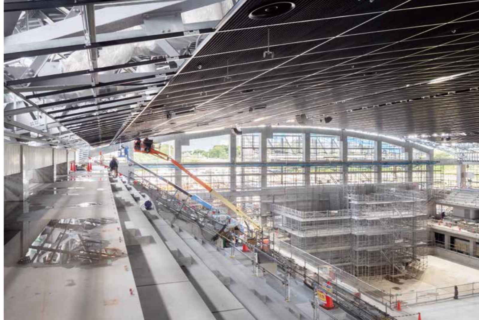
南側の観客席最上部から。天井の曲線形状と、その内部の設備が見える。写真右下は飛込用プール。
