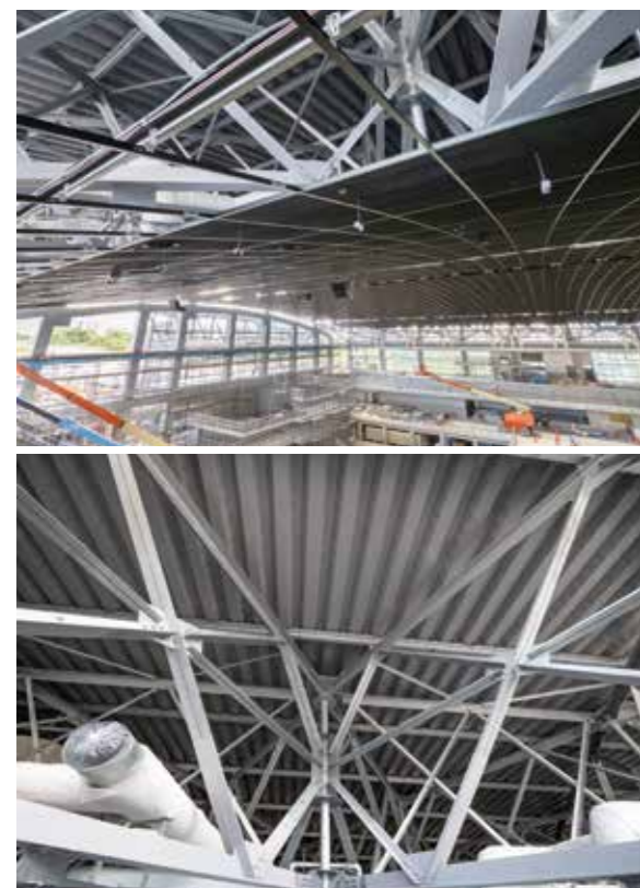
上/防音パネルの内側には、複雑なトラス構造の鉄骨と配管が見える。 下/トラス構造を構成するダイヤモンドトラス。剛性が高く、大空間の建築に適している。
