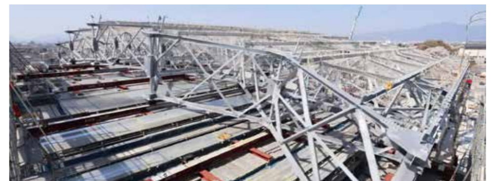
スライド工法による屋根鉄骨の架設状況。手前の構台上で組み立てて一つ前のスパンと接合し、写真奥から引張る。その繰り返しにより、約3.5カ月で屋根を施工した。(画像提供:前田建設工業株)
