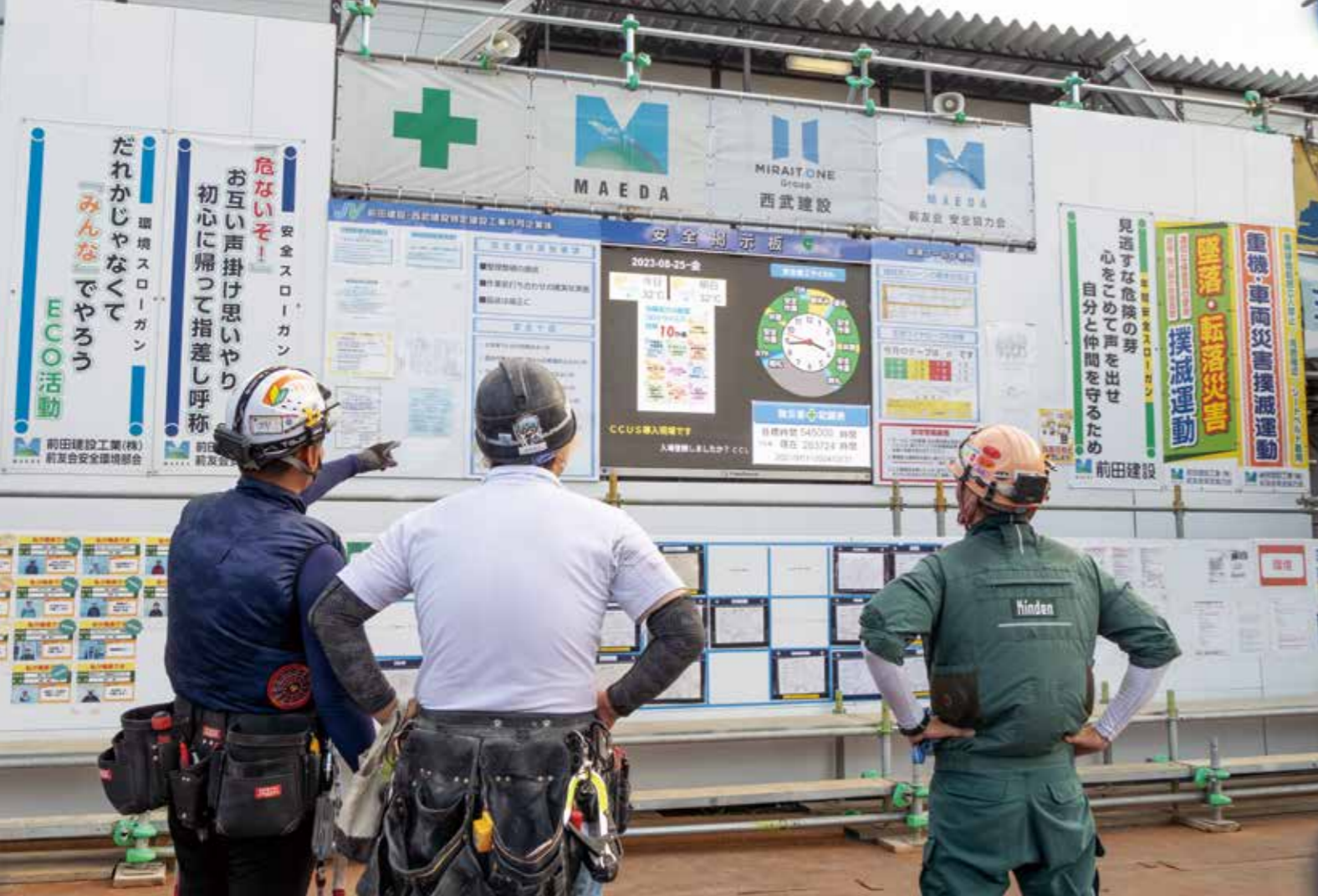
朝礼看板のデジタルサインージ。この時間ごとに内容が変わる掲示資料の作成を「工務センター」に委託することで、「製作」と「貼り出し」の2工程が簡略化された。
