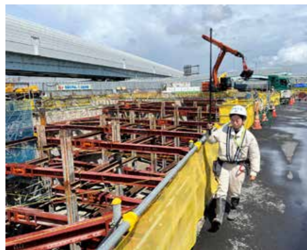
上／360°カメラの映像とBIM/CIMモデルの比較。映像の画角を変えるとモデルも連動し、同じ角度で進捗状況を比較できる。(画像提供：OpenSpace UIより抜粋) 左／棒の先に付けた360°カメラで撮影しながら現場内を1周するだけで、ストリートビューのように任意の角度から各所を確認できるようになる。(画像提供：清水建設株)
