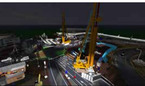
点群データを基に作成したVRの交差点。重機や仮囲いは原寸に忠実に製作したモデルを使用し、夜間工事のシミュレーションに活用した。(画像提供: 清水建設株)
