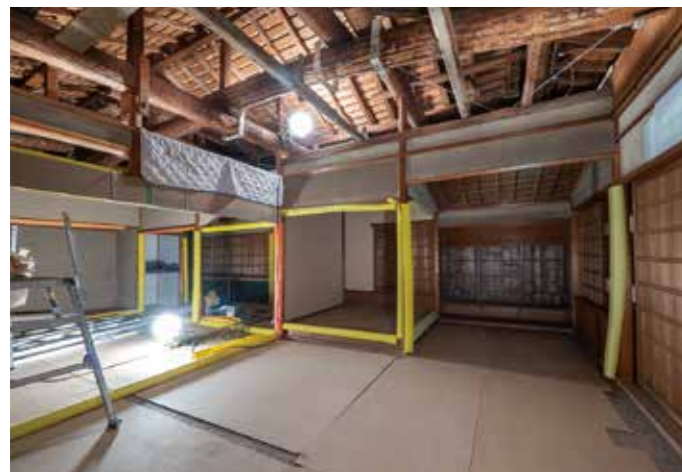
天井裏にプレース材を設置して建物がねじれる挙動に対応。白いロープでモデルをつくりプレース材の最適な設置ポイントを検証する。
