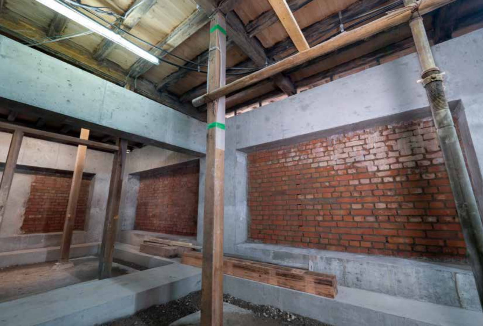
地下に設けられた煉瓦の基礎部の施工を残し伝えることも考慮してRCの構造物を構築し、鉄筋と一体化させて茶室全体の耐震性能を強化する。
