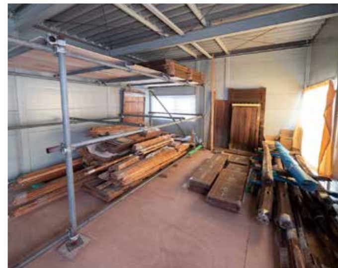
保存小屋には正門の板戸や天井材など撤去した部材が保管されている。正門の柱には過去に接ぎ木で修理された形跡がある。今後腐敗や損傷の程度を検証してその接ぎ木を残すか、切断して新たな材料で接ぐか検討するという。
