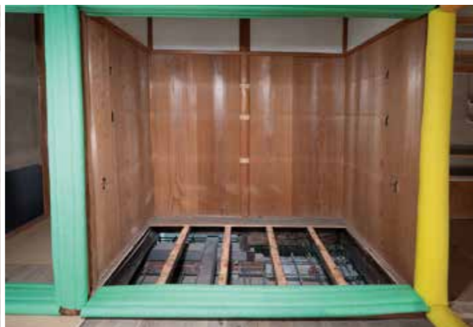
茶室内にある4カ所の押し入れの内側に基礎を施し柱を立て、三面に格子パネルを設置する。これが耐震壁となり水平方向の揺れに対して抵抗する。
