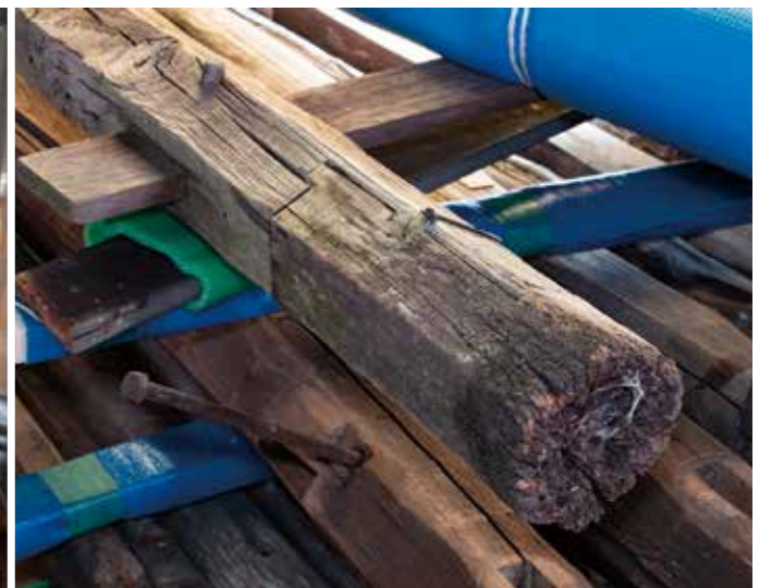
保存小屋には正門の板戸や天井材など撤去した部材が保管されている。正門の柱には過去に接ぎ木で修理された形跡がある。今後腐敗や損傷の程度を検証してその接ぎ木を残すか、切断して新たな材料で接ぐか検討するという。
