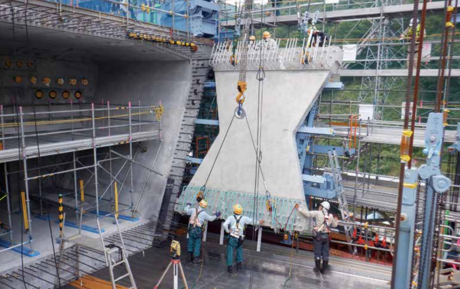
架設中の大型バタフライウェブ。「軽量」とはいえ大きいものでは1枚が10t以上あり、工法そのものも新しいため慎重な施工が続く。(画像提供：三井住友建設株)
