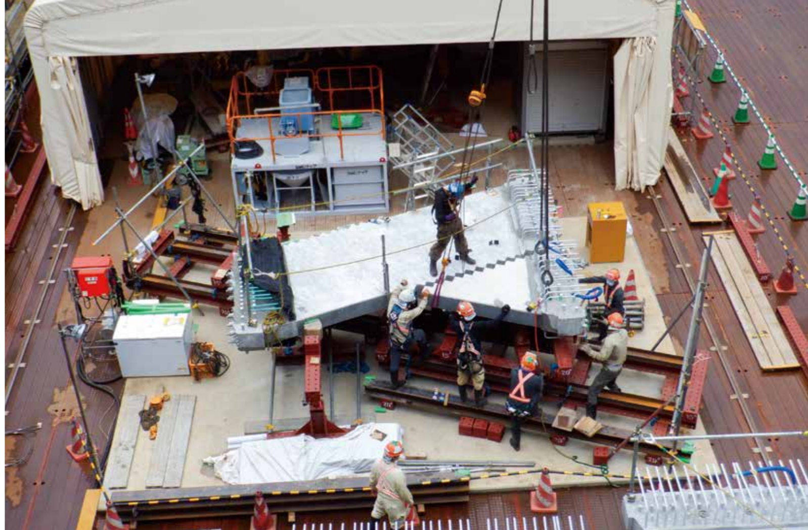
大型のバタフライウェブはトレーラーで運べる大きさに分割し、現場で接合・一体化している。(画像提供：三井住友建設株)
