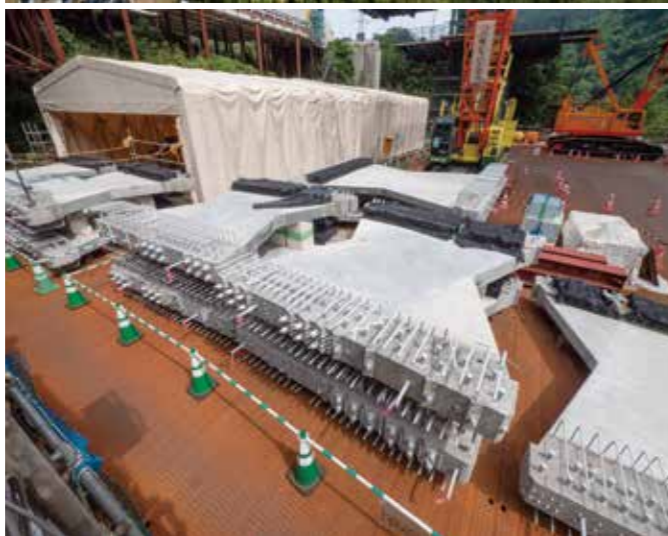
上・下／現場内でストックされているバタフライウェブ。大量の部材を置いておく敷地を有することも、この工法に欠かせない要素となる。
