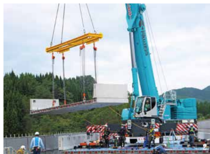
1. ①専用治具による引寄せ ②ボルト締付け ③目地材充填完了（接合完了） ④床版取替完了（舗装前） 2. 壁高欄一体型床版架設 3. コッター式継手
