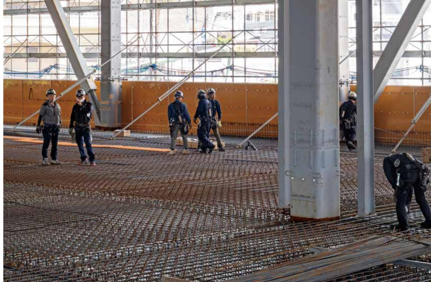
スラブ配筋中の1階部分。こうした作業状況はWEBカメラでいつでも確認できる。
