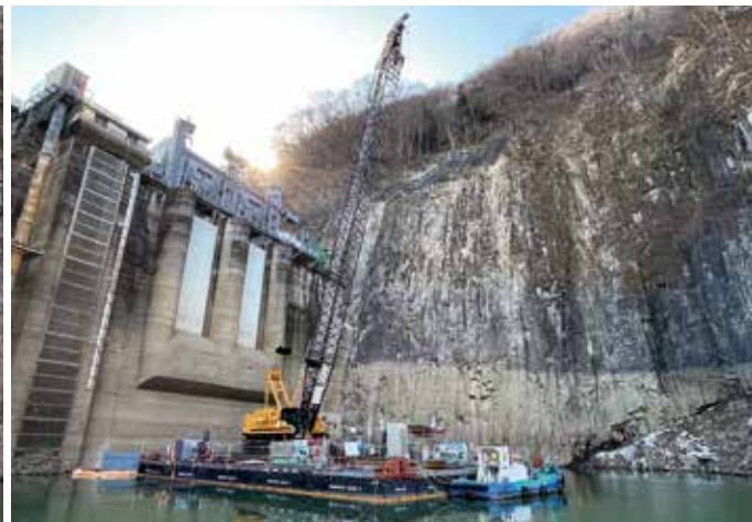
上左／ダム湖百選にも選ばれた赤谷湖。谷川岳を眺望する絶景が多くの観光客を呼ぶ。 上右／新たな放流設備は右側のクレストゲートの直下に新設される。(上右写真出典：国土交通省R3相俣ダム改良事業パンフレット) 下左／昨年度の渇水期に上流側に掘え付けられた扉体と戸当り。 下右／戸当りとこれを施工するための仮締切の組立てにはクレーン台船を導入した。(下写真2点提供：飛鳥建設株)
