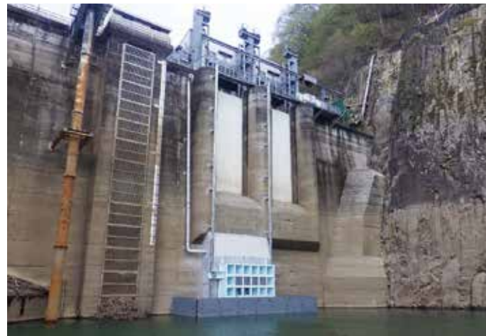
上左／ダム湖百選にも選ばれた赤谷湖。谷川岳を眺望する絶景が多くの観光客を呼ぶ。 上右／新たな放流設備は右側のクレストゲートの直下に新設される。(上右写真出典：国土交通省R3相俣ダム改良事業パンフレット) 下左／昨年度の渇水期に上流側に掘え付けられた扉体と戸当り。 下右／戸当りとこれを施工するための仮締切の組立てにはクレーン台船を導入した。(下写真2点提供：飛鳥建設株)
