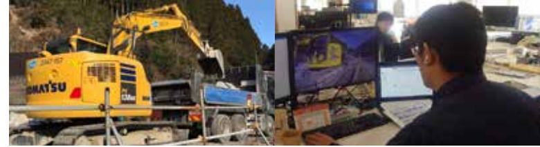
現場には多様なICT施工技術、DXが導入された。CIMによる4Dシミュレーションを実施、施工計画上の生産性・安全性の確認に活用した(写真上)。当時から場内各地にカメラを配置し施工状況の常時監視による安全と品質の確保を図った(写真下)。
