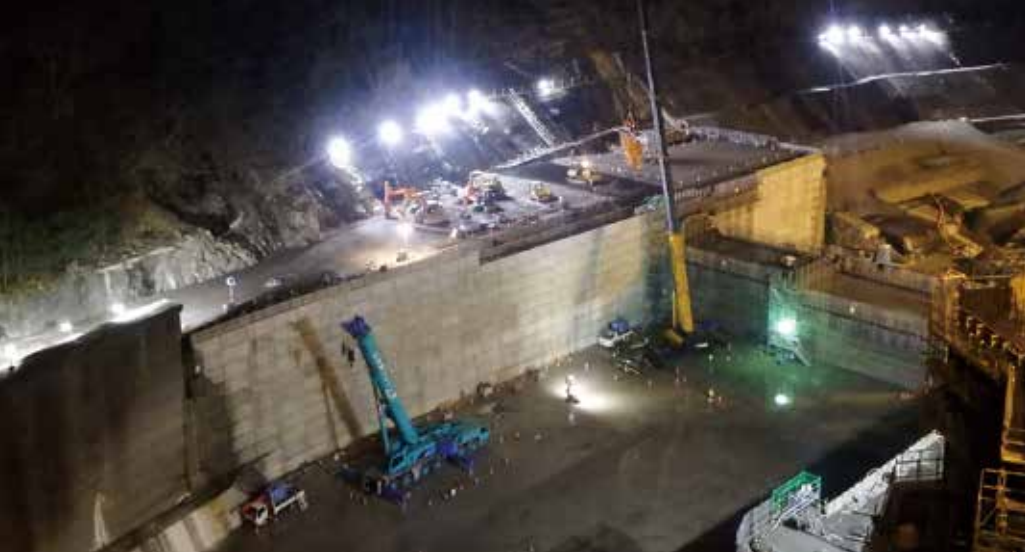
プレキャストブロックをクレーンで積み上げることで足場や型枠を使わずに減勢工の側壁を構築した。
