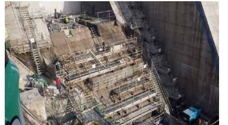
上流側に予備ゲートを構築した後(写真上)、下流側の既設堤体をブロックに分割して撤去した(写真下)。
