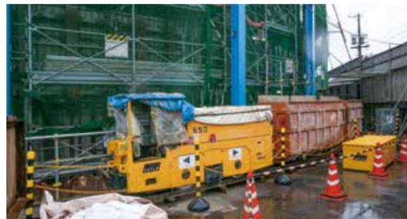
西側で運び上げた掘削土砂を専用のロコで東側のヤードに運ぶ。ケーソン外径が敷地ぎりぎりなので、西側と東側との往来が難しく、このような方法での運搬となった。
