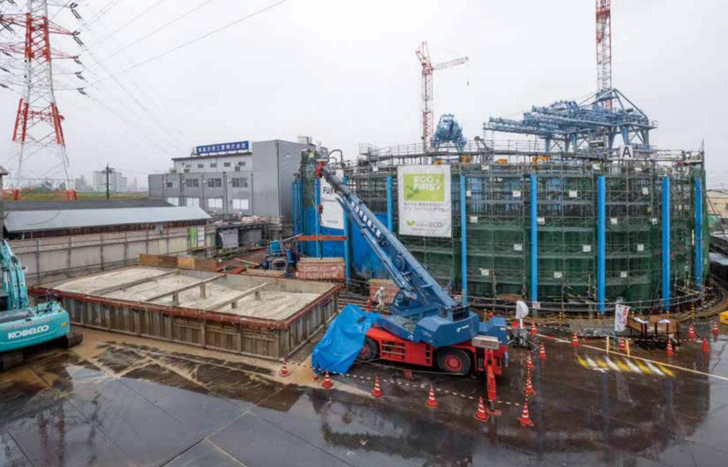
東側から見た現場の概況。西側で運び上げた掘削土砂を東側のピットにストックし、その後搬出している。
