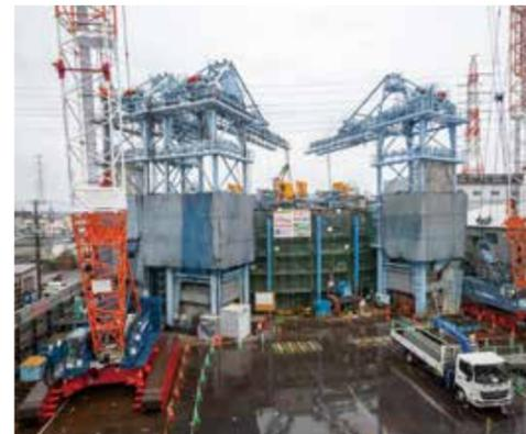
ヤードの西側から見た函体。写真奥の東側に送電線があるため、掘削土を搬出する槽は西側にしかない。
