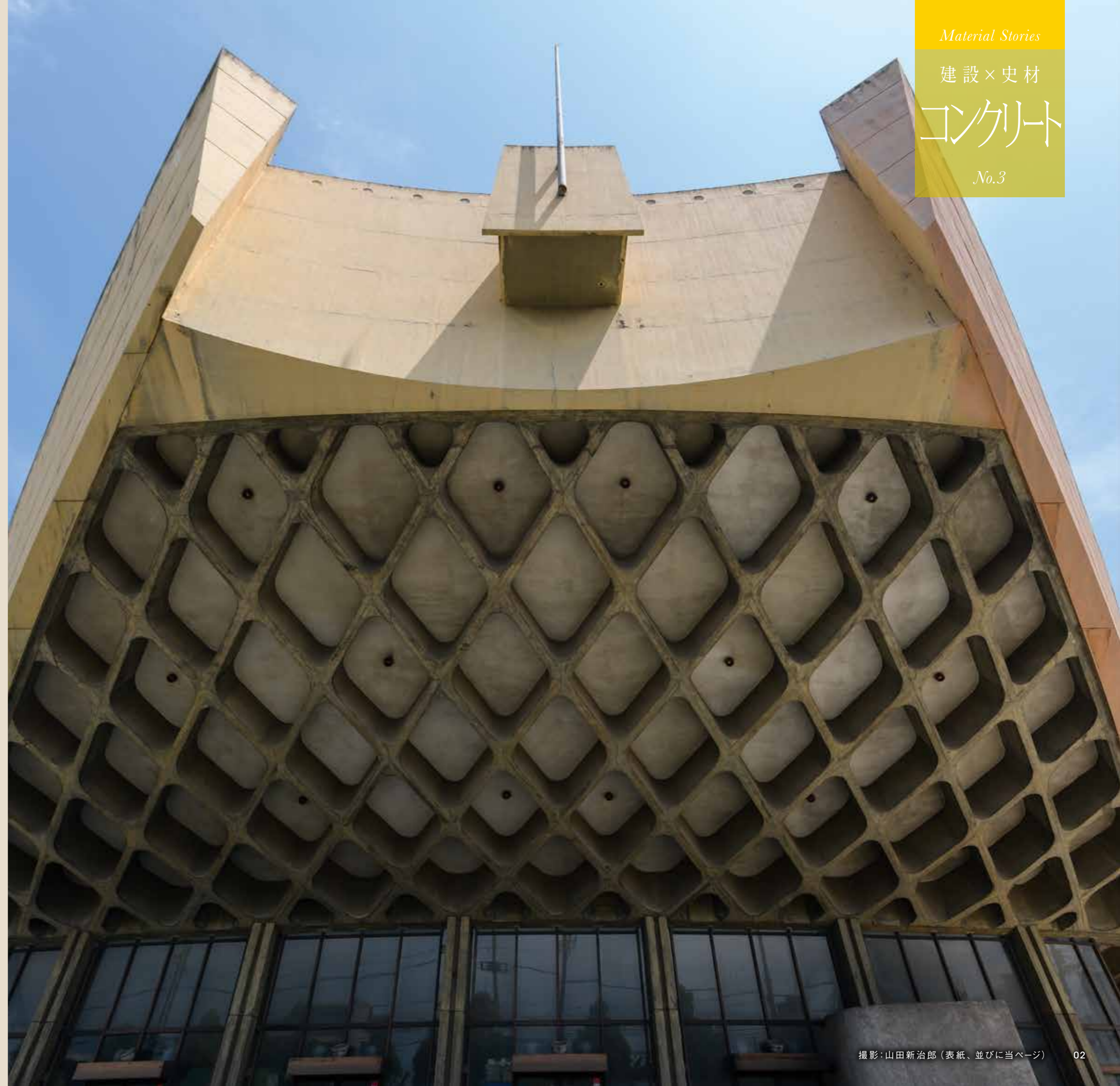
プレストレスコンクリート一部鉄筋コンクリート造、吊り屋根構造3階建て延べ4,707㎡、固定座席1,300席の規模をもつ。吊り屋根構造による美しい曲線を描く大空間が、国立代々木屋内総合競技場のプロトタイプと言われる所以である。内部は老朽化と耐震不足のため2014年から閉鎖されている。（内観写真は2011年3月撮影）
