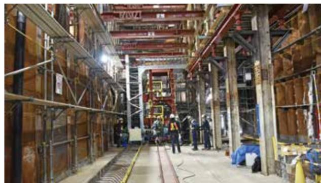
施工中のPPCaボックスカルバート。頂版・側壁部材が中空であることがわかる。プレキャスト部材は、BCCS(ボックスカルバート・キャレッジ・システム)工法で奥へスライドさせた。(画像提供:東急建設株)
