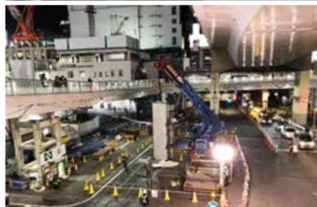
PPCaボックスカルバートの部材搬入作業を、4Dシミュレーションと実施工で比較。クレーンと高架との干渉などを事前確認できたことで、生産性が向上した。(上・下画像提供: 東急建設株)
