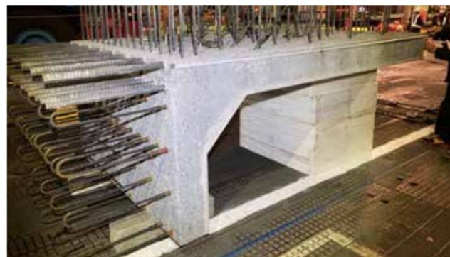
工場製作した頂版部材。各種鉄筋を内蔵し、現場設置後は側壁との接合とコンクリート打設を行いボックスカルバートが完成する。(画像提供:東急建設株)
