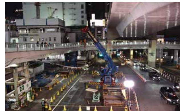
歩道橋から見下ろした現場の昼と夜。深夜は車線規制して覆工板を取り外し、開口部から各種部材を地下に下ろす。覆工板を外したり設置したりする作業があるため、実施工の時間は限られてしまう。(左画像提供:東急建設株)
