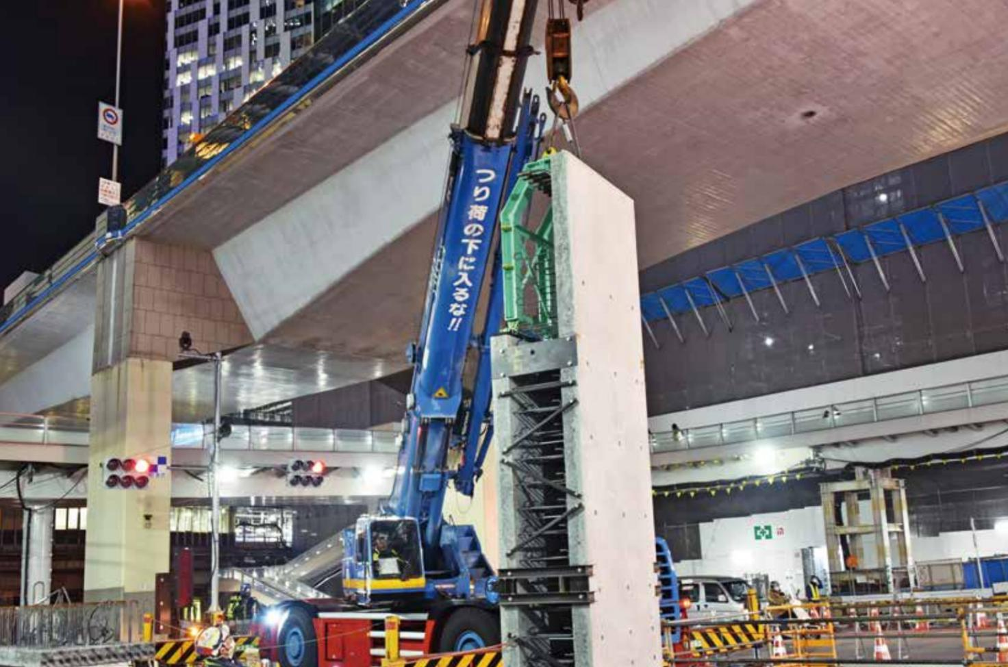
PPCaボックスカルバートの現場搬入状況。1車線を残して国道246号を規制し、上空の首都高速3号渋谷線の高架にも注意しながらの施工となる。(画像提供:東急建設株)
