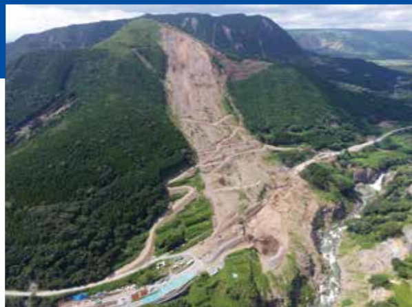
2016年熊本地震で崩壊した南阿蘇村の斜面対策工事。二次災害を防ぎながら緊急の防災対策を講じることが求められ、無人化施工を現場に全面展開。調査・設計・施工プロセスをデジタル化により一体化し、全工程においてi-Constructionと連動した緊急時の新たな事業マネジメントを実現した。
