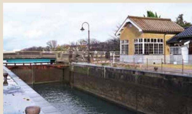
昭和30年代にトラック輸送が主流になると、運河と閘門はその役割を終える。埋立も検討されたが、県は保存と再生を決断し老朽化した中島閘門も1998年に蘇った。富岩運河一帯は親水公園として整備され、市民に愛される憩いの場となっている。中島閘門も観光船を往来させる水運施設として現役で稼働している。
