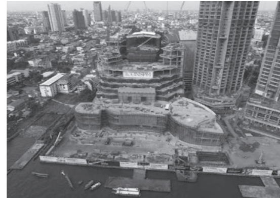
現況：外装工事と内装工事が進行中(2017年末撮影)
