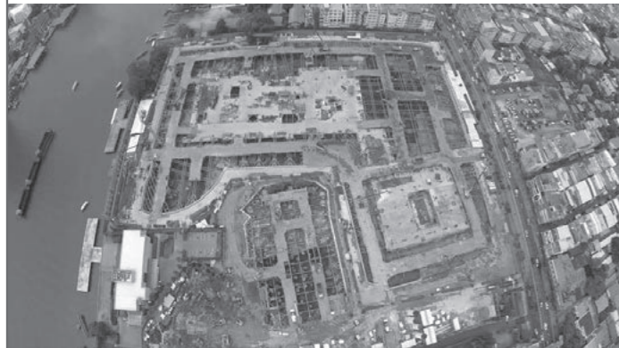
地下工事全景：逆打ち・アイランド工法を採用
