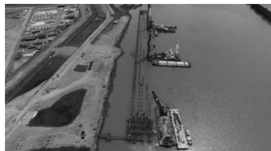
揚炭栈橋、奥が杭打ち工事、手前が上部工。
