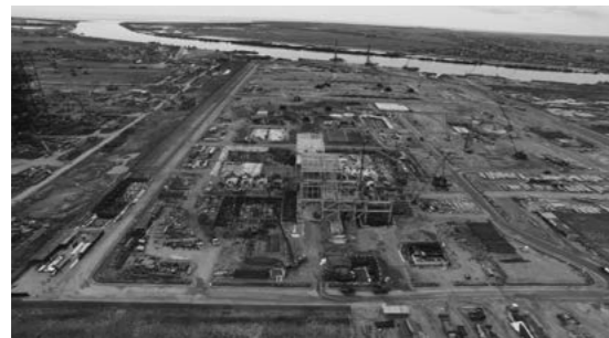
陸上土工事と各種構造物の建設が同時進行中。
