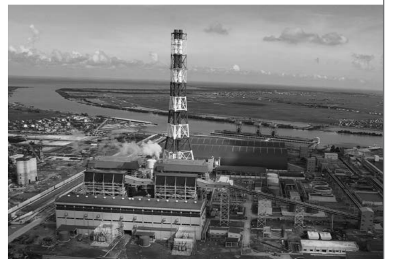
手前左側から発電所の心臓部であるタービン発電機建屋、その後ろが石炭バンカー、ボイラー、煙突、貯炭場。右側は水処理・排水処理施設。
