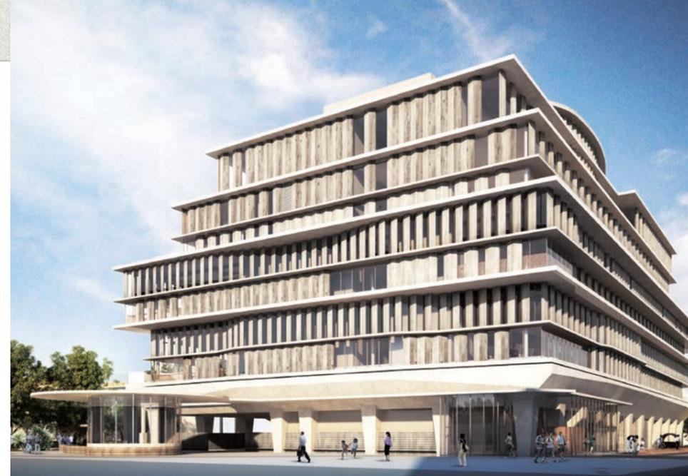
オーテピアの南西側の外観パース。「大きな樹」をイメージしたデザインとなっている。GRC木目化粧パネルで木の質感を再現したルーバーで覆われている。西側には全国で3例目の円筒形の機械式地下駐車場も設けられる。(提供：高知県教育委員会)
