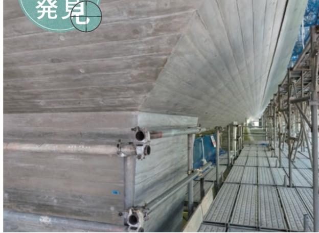
1階外周の柱と梁。打ち放しコンクリートの型枠の内側に杉の縁甲板をセットし、木目を写し取った。木の根っこをイメージしたダイナミックな造形である。
