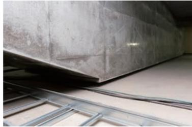
免震層内に施工した現場打ちPC梁。梁の高さ2.3m、幅1.8m、長さ18mに及ぶ梁の底部のクリアランスが8.5cmという異例の狭さ。この寸法で型枠を設置・取り外すために、底部下に砂とスタイロフォームを敷き込み、ベニアの型枠を組んだ。コンクリートの硬化後に砂を吸い出して取り外しを可能にしたという現場の知恵の産物。
