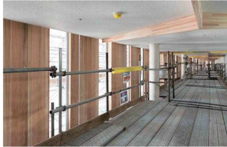
図書館2階から3階、2層吹抜けの天井部。高知県産杉材を集成し、意匠的な木リブを取り付けている。オーテピアの天井は耐震天井になっている。
