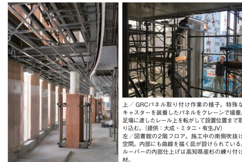
上／GRCパネル取り付け作業の様子。特殊なキャスターを装着したパネルをクレーンで揚重。足場に渡したレール上を転がして設置位置まで取り込む。(提供：大成・ミタニ・有生JV)
