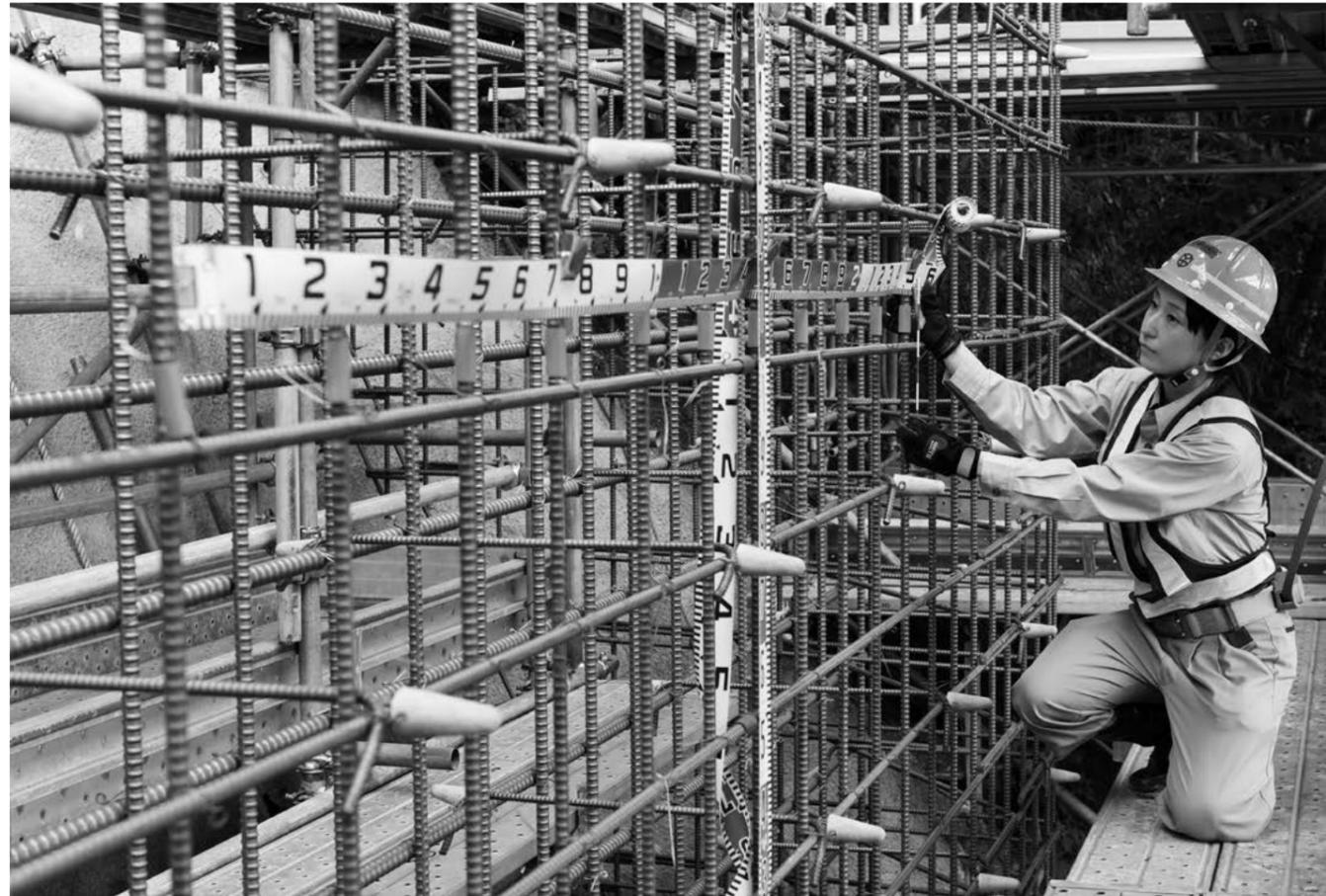
この現場で新たに取り組み始めたトンネル入り口の坑門工事。鉄筋組立が完了し出来形確認を行っている。
