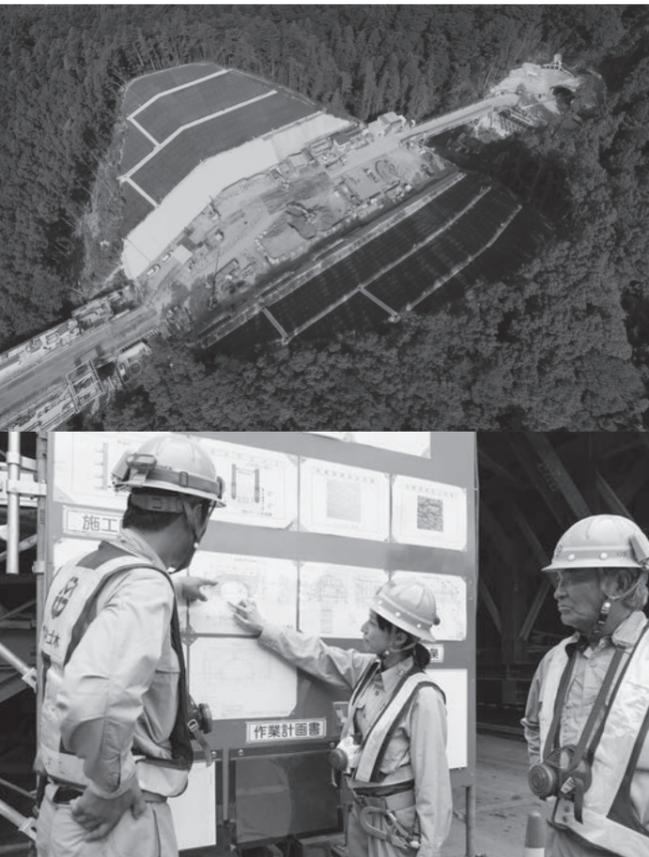
上/全長2,087mの城山トンネルのうち、1061.5mを施工する。両側から掘り進め11月に貫通予定。
