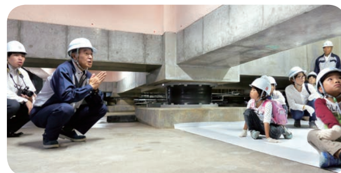
探検するようにしゃがみこみ、地震の揺れから建物を守る免震装置の役割を知る。
