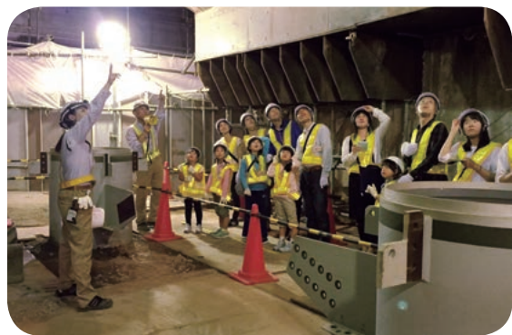
上／VR（バーチャルリアリティ）による安全教育を体験。 中／入り口から約650m奥の切羽付近で、作業用の重機に乗り 完成する前のトンネルをじっくり観察した。 下／明治時代につくられたレンガアーチ高架橋をSRC化する 現場を見学。耐震性能を強化するために採用してる技術の説明 するけんせつ小町。
