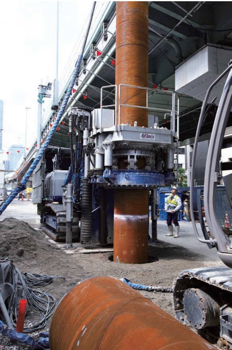
鋼管杭施工では、低空頭条件下で施工できるアルファシステム工法を採用。継手箇所を削減し、工費、工程を圧縮した。
