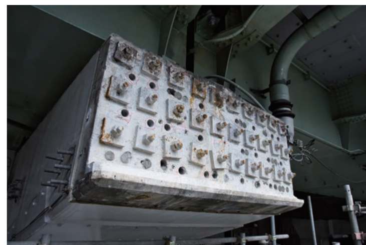
既設の梁は、その健全性を保つためウォータージェットではつり、アンカーで緊張を加えた後、新しい柱につなげていく。既存の主筋を傷めないよう探査しながら慎重に作業を進めた。
