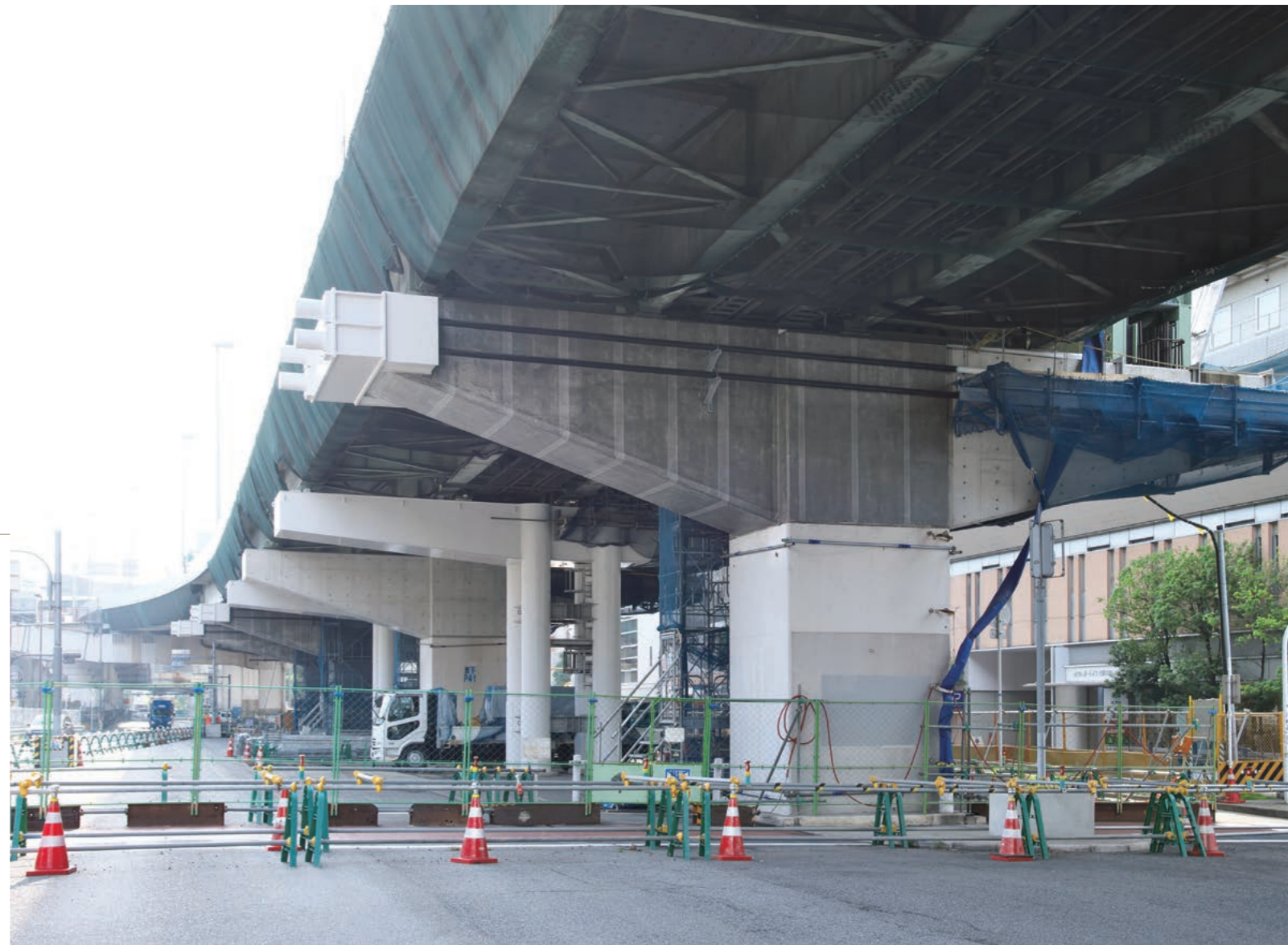
既存の柱、梁と新設したRC梁を一体化させ、梁部は外側からPCケーブルで緊張し強度を確保する。その奥側に見えるのは4本の鋼管とこれをつなぐせん断パネルで構成された鋼管集成橋脚。大規模地震が発生した際に、あえてパネルを損傷させ、水平方向の荷重を吸収することで他の部材の損傷を抑える。地震後もせん断パネルのみの交換で橋脚自体の修復も容易に行える。
