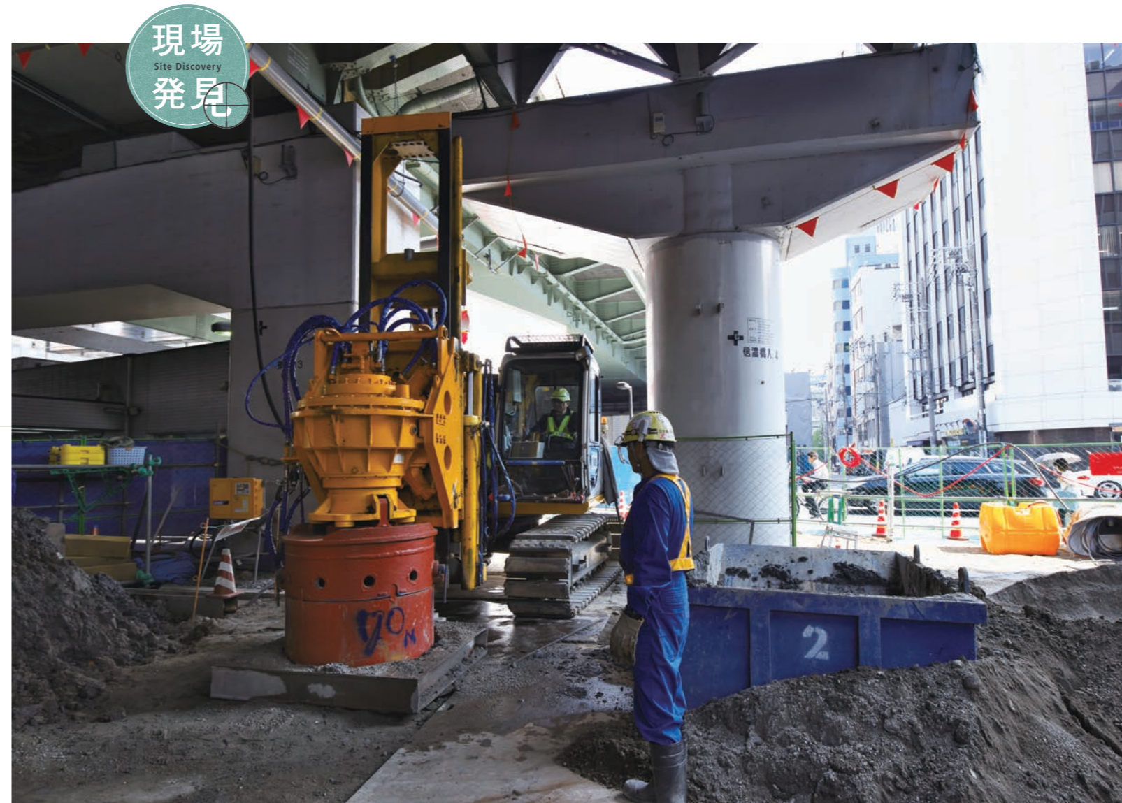
自走式掘削機が円筒状のケーシングを回転させ、埋設物を砕きながら地中に圧入していく。その横には江戸期の護岸だろうか、撤去した石がゴロゴロと積み上げられていた。一帯からは建物の基礎コンクリートやレンガ、転石など様々な埋設物が出てきた。
