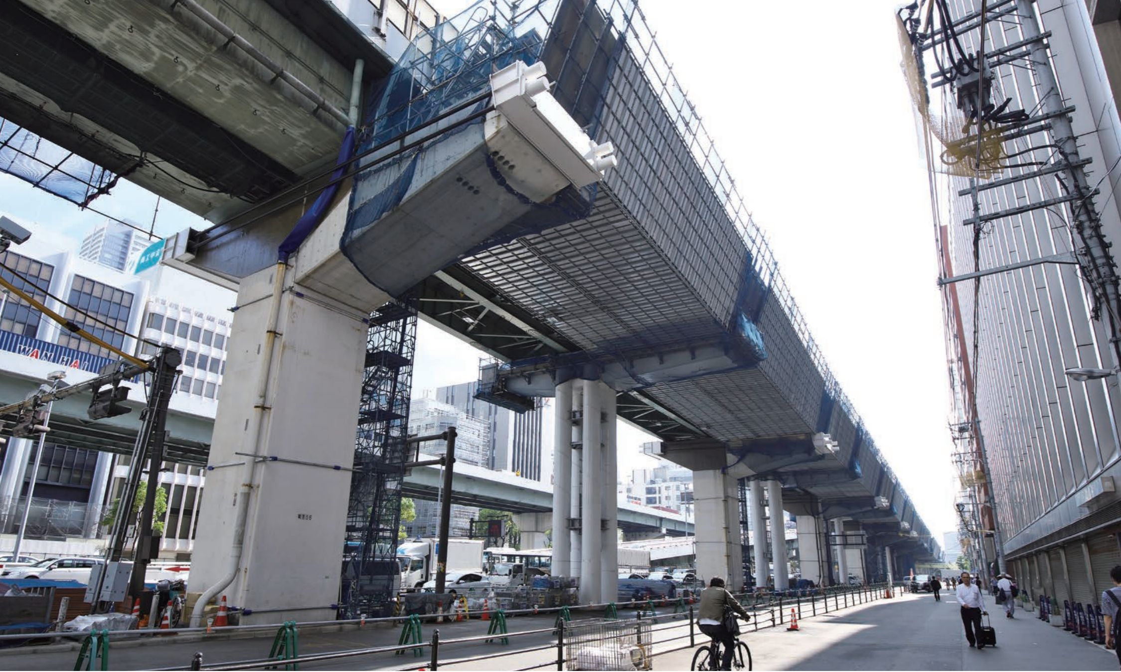
高速道路の拡幅にとまじり、新たな桁を受ける梁を外側に向けて増設する。周囲はオフィス街で人通りも多い。桁の中央を走る高速道路は工事中も供用される。40年以上前のインフラを再生する緊張感の高い現場だ。
