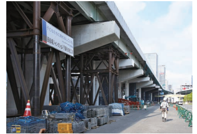
高速道路を仮受けするベントの基礎杭は支持層にまで達する、ほとんど本設といってもいい強靱さだ。工事中に大型地震が発生しても十分に耐えることを考慮した。このベントを足がかりに既設の梁の撤去、RC梁の再構築を行った。
