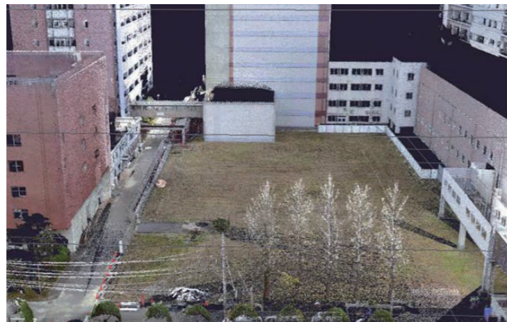
3Dスキャン測量による既存建物の把握。(提供：戸田建設株)
