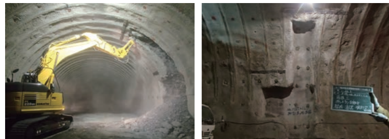
標準断面の支保工が完了した後、切羽の進捗を待って支保工を撤去、水平方向に拡幅して改めて支保工を施工する。
