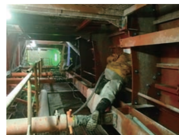
通常の締固め作業の様子。
