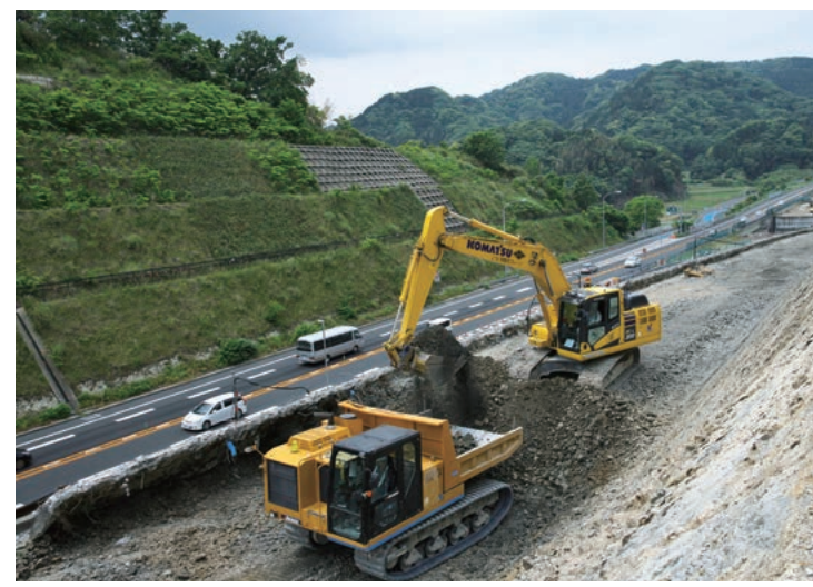
高速道の直上で切土の工事が進む。石粒一つが重大事故につながる懸念もあるため、落石防止策を施し慎重に作業を行っている。
