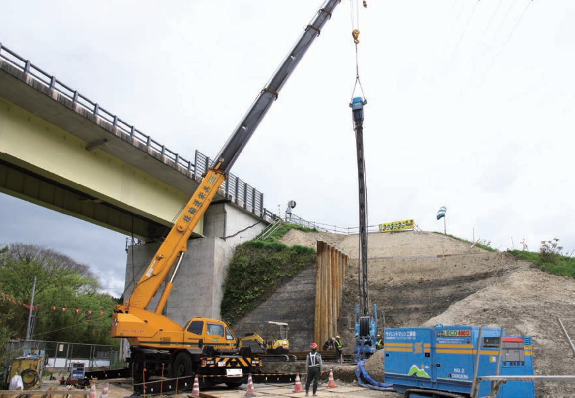
天然アユの漁場である相川の近傍での施工は、工事用排水の出ない硬質地盤対応圧入工法を採用するなど、環境への配慮も怠らない。
