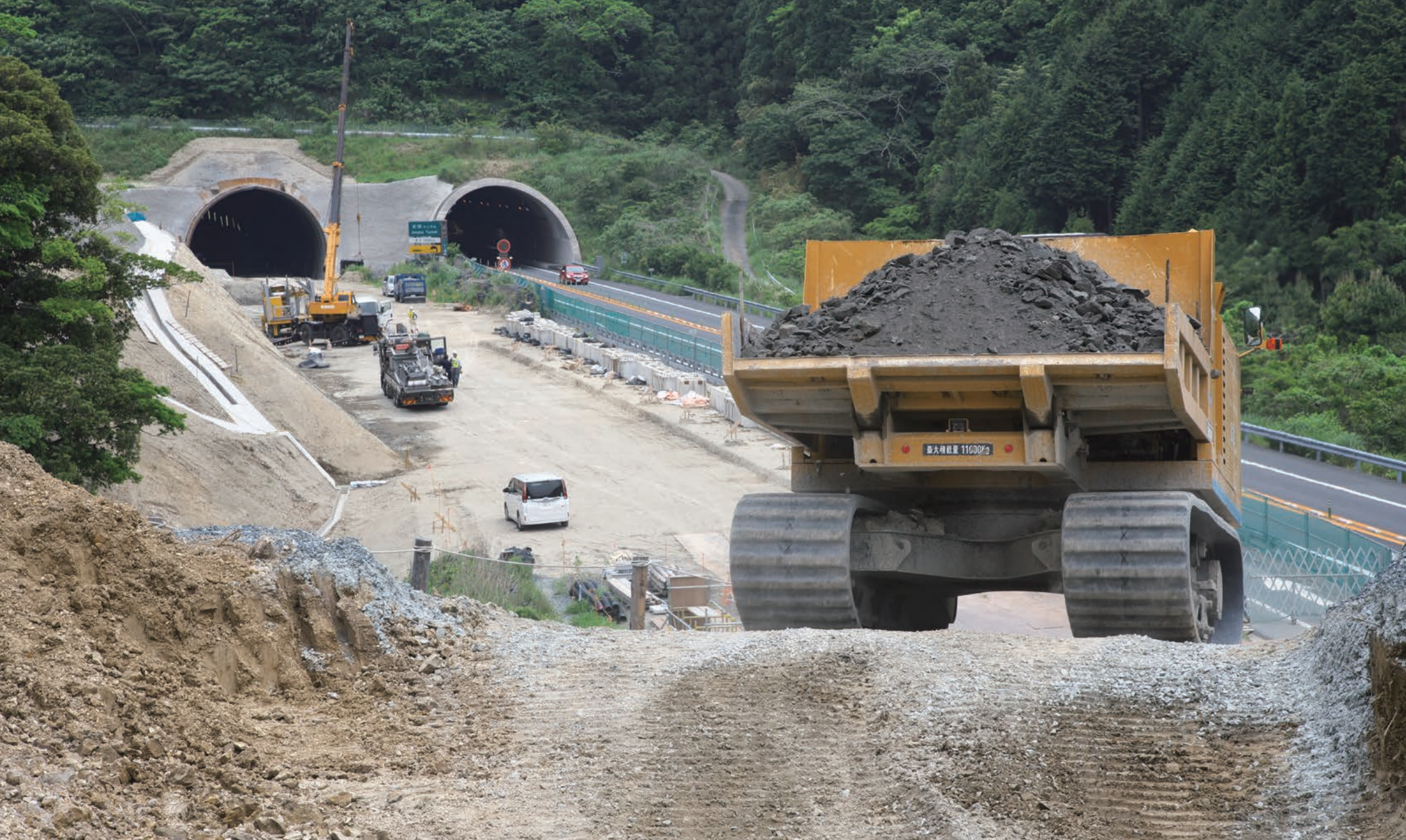
既設のトンネルに並行してほぼ同じ仕様の新たなトンネルを貫通させた。その外では坑口に迫る山を切り崩し、拡幅する車道のスペースを確保する造成工事が展開する。
