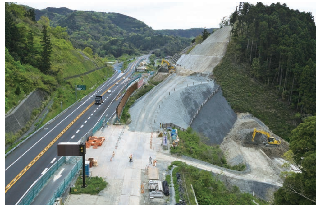
斜面を伐採し、落石防護柵を設けた後、重機を登坂させる工事用の通路を造成、山の上部から下方に向かって切り下げてくる。土砂を運搬する工事車両が高速道経由で現場に進入することもあり誘導には細心の注意が払われた。
