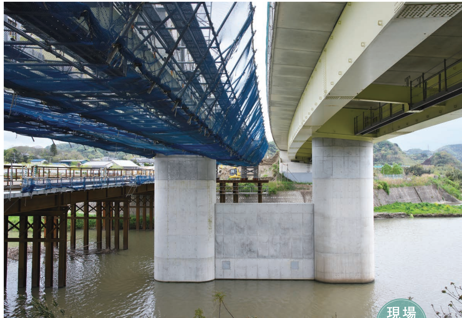
川を横断する施工用の栈橋を設置し、既存の橋脚と一体となるような新たな橋脚を施工した。下部工はすでに引き渡しを終えた。次の工程に向け橋桁がベントで仮受けされ、本架設の時を待っていた。
