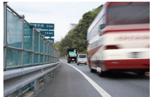
路肩の幅は約2m。そこに幅1.5mの施工機械を搬入して防護柵を施工した。目の前の供用線では時速100km近くで車が走り抜ける。常に逃げ場を想定しながらの作業になった。仮設防護柵、落石防護柵の総延長は6km近くに及んだ。
