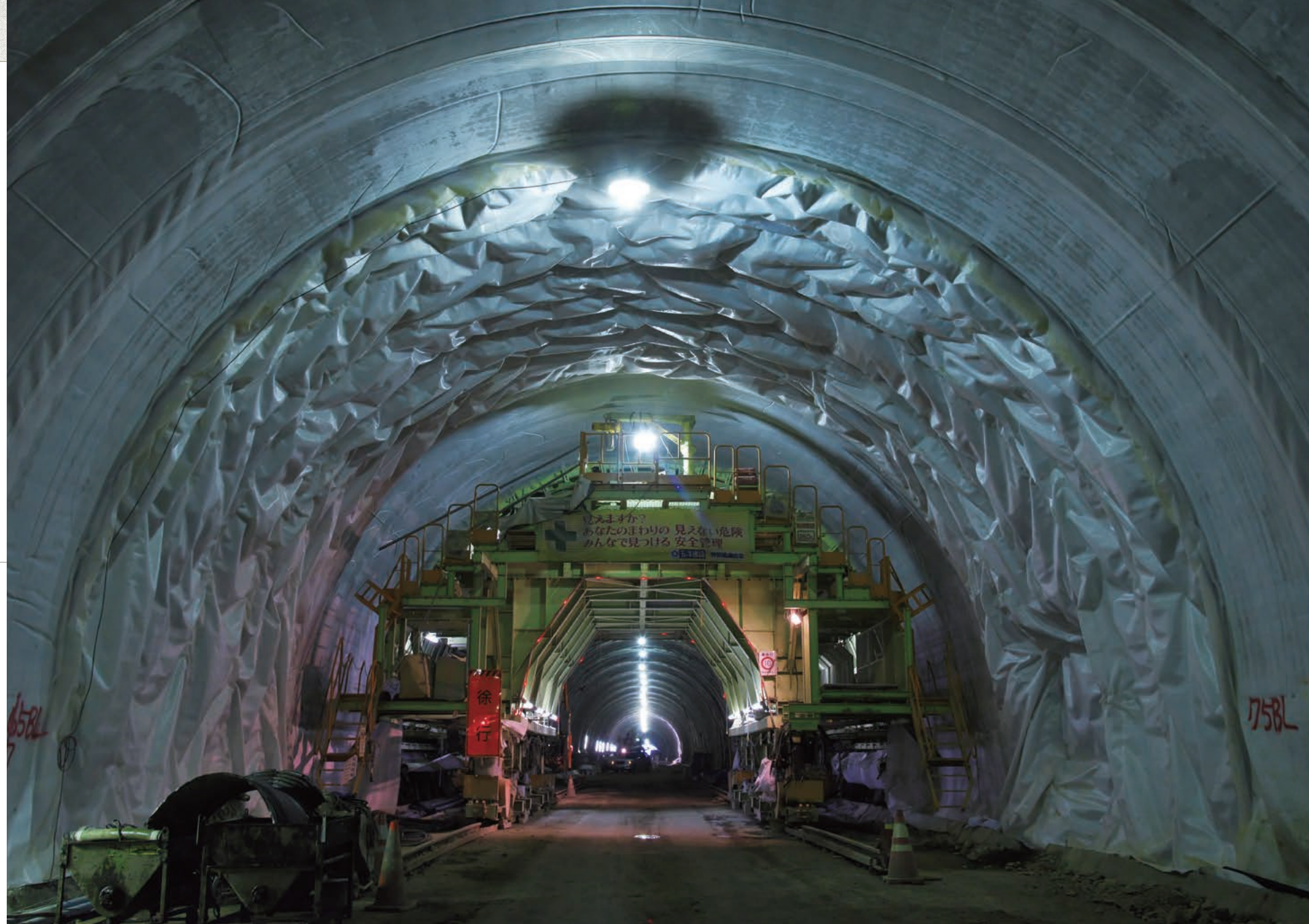
トンネルの坑内では側壁、インバートの覆工が進む。掘削時には坑口にプラントを設置し、掘削土はベルトコンベアで排出した。昨年末の安全パトロールでは参加者から、粉塵が少なく視界も確保されていると高い評価を得た。
