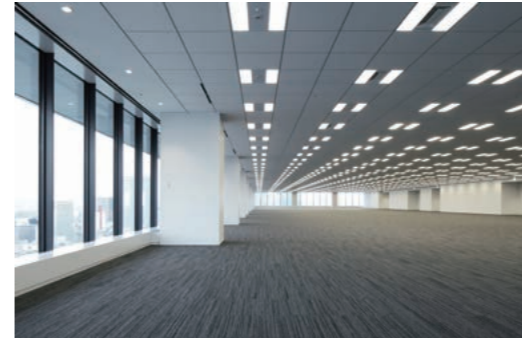
大庇と連続する事務所階の天井
