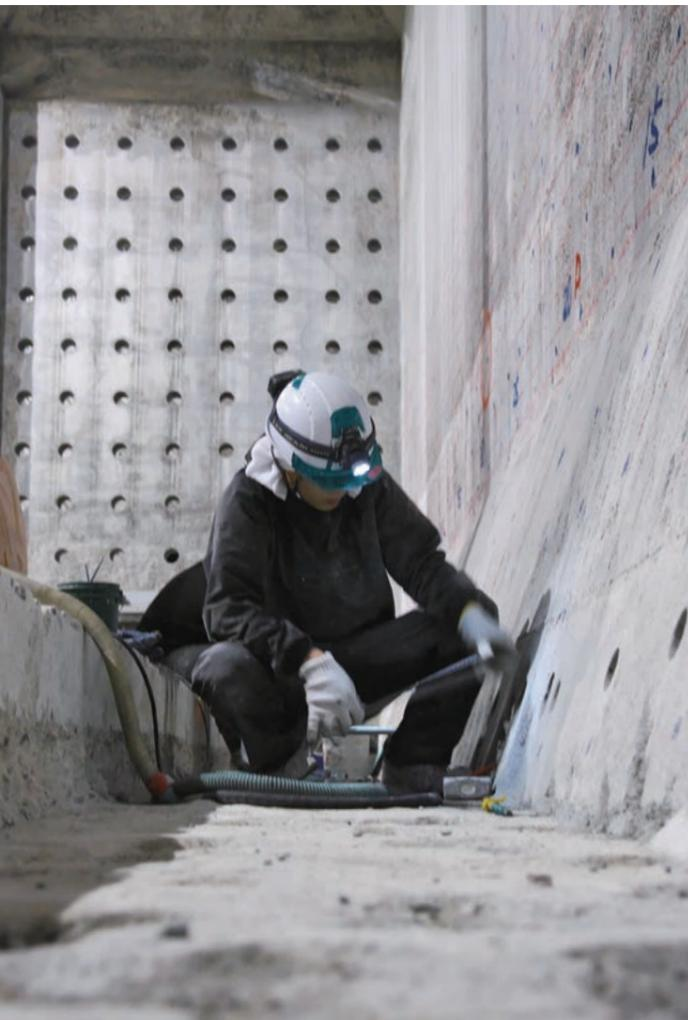
浄水池の下部は底盤がせり上がり、通常の施工機械が入らない。小型のコアドリルで削孔し、短尺のアンカーを継手でつなぎながら埋め込んでいく。高度な技術が要求される繊細な施工だ。
