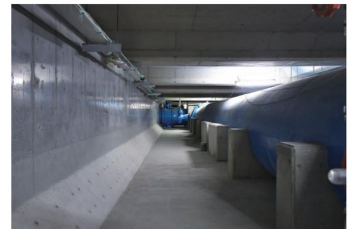
地下3階の管廊の壁面施工ではバイブレータが入る床から1mまで通常の生コン、その上は高流動コンクリートを流し込み、天井付近は無収縮モルタルを打設した。狭隘なうえに、地上の生コン車から200mの配管を回す難しい工事だった。
