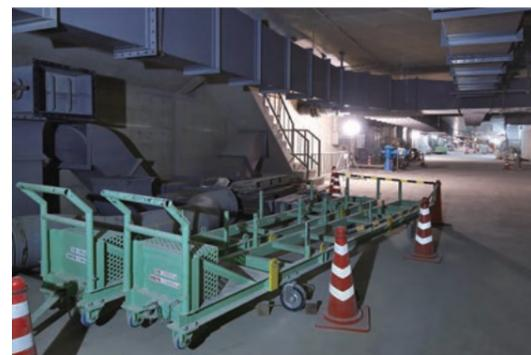
右/地上から降ろされた鉄筋を運搬するためにオリジナルの台車を本社と共同で開発した。手作りの発想で現場での困難な課題にも柔軟に対応する。左/浄水池への入り口はここ1カ所だけだ。天井クレーンを設け、すべての機材、資材をここから搬入した。
