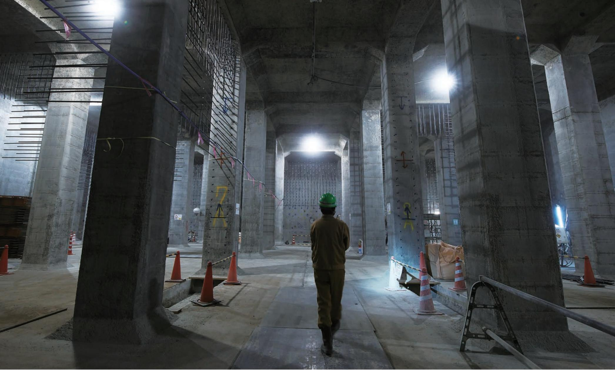
水を抜いた浄水池の内部は地下神殿のようだ。5mピッチで並ぶ柱の間、63カ所に隔壁を新設し耐震性を高める。左手の柱上部に見えるのが「あと施工アンカー」。施工後はこの部分为新設の壁になる。
