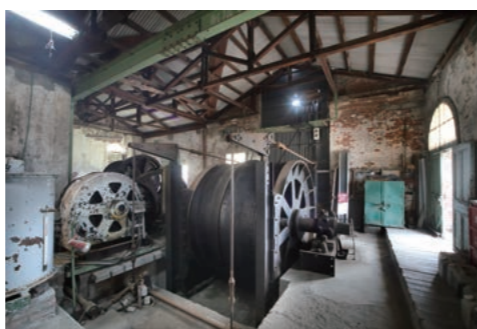
堅坑へのケージの昇降を制御するワイヤーロープの巻揚機。昭和にかけて補修、補強の跡があるが、当時の姿がそのまま残されている。
