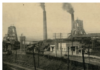
明治時代の宮原坑。揚炭や入気、排水、人員昇降等を兼ねる主力坑として年間40～50万tの出炭を維持した。(提供：大牟田市石炭産業科学館)
