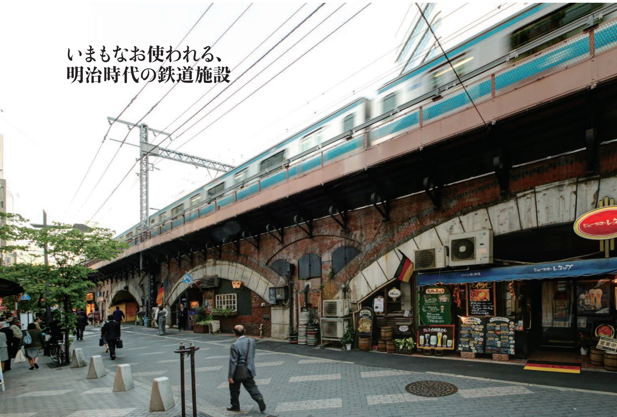
東京～新橋間のレンガ造のアーチ型高架橋も完成は明治年間。100年以上も現役の鉄道施設として今日まで機能する。目をこらすと繊細と無骨が同居するその意匠に当時の建築家の矜持を見ることができる。
