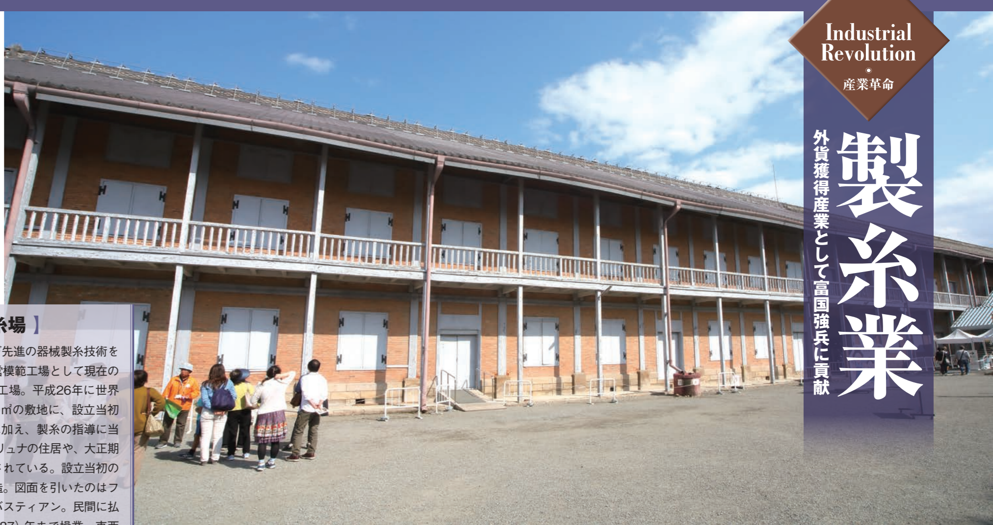
1階が事務所と作業場、2階には乾燥させた繭を貯蔵した東置繭所。木材で骨組みを造り、壁面の仕上げに煉瓦を用いる木骨煉瓦造で建造された。
