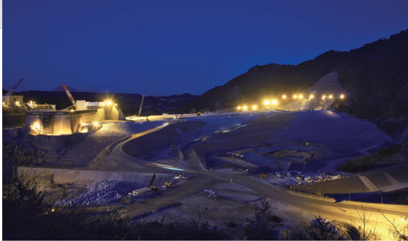
夕暮れ時、照明が灯された現場は日中と異なる幻想的な姿を見せる。
