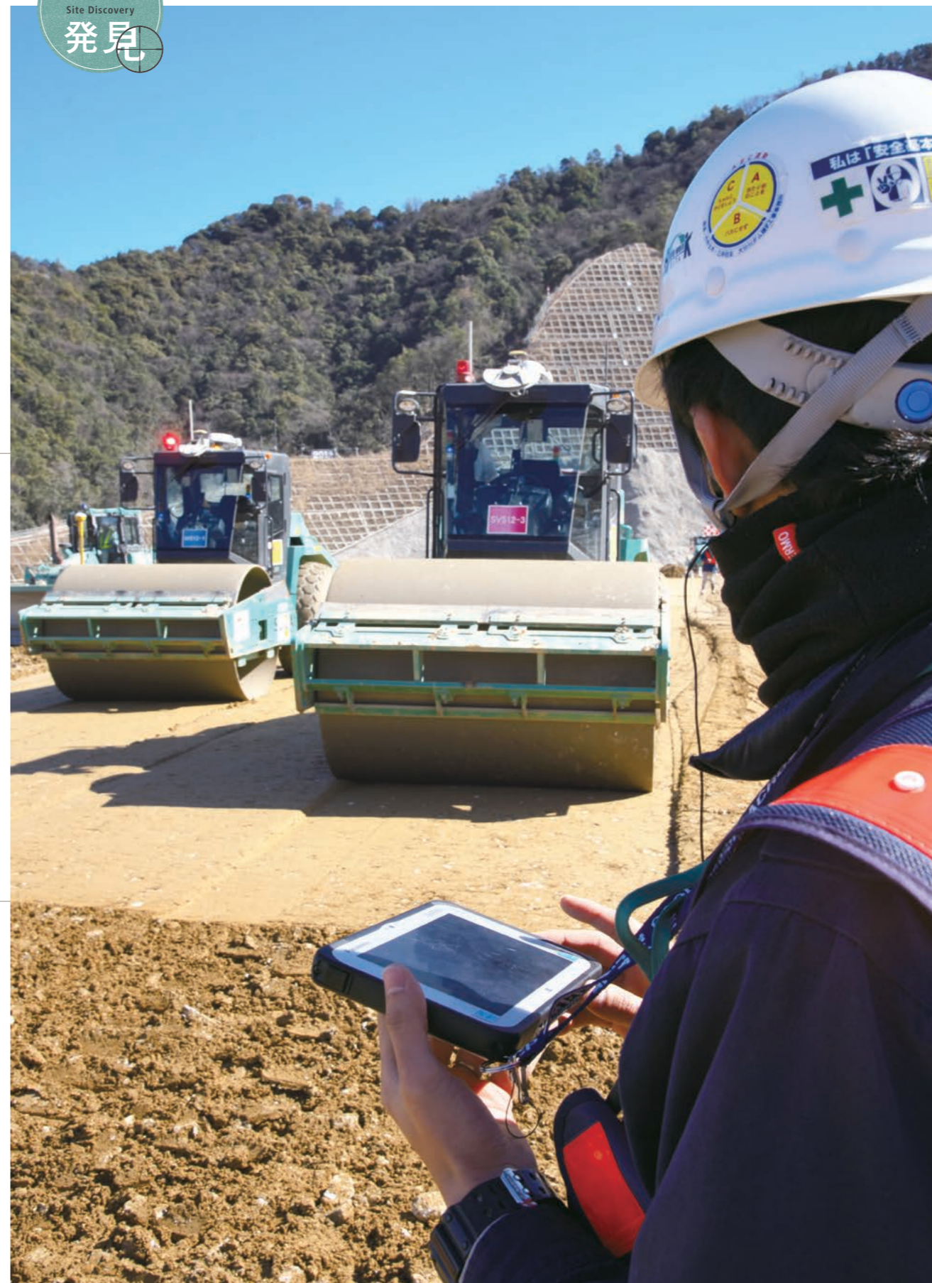
複数台の無人振動ローラを1人の作業指揮者が見守る。その誤差は±10cm以下。締め固めは20cmラップさせて施工するが、その精度は熟練オペレータに引けを取らない。操縦席の上部にある半円形のレーザースキャナーにより、人の接近を感知すると自動停止する。
