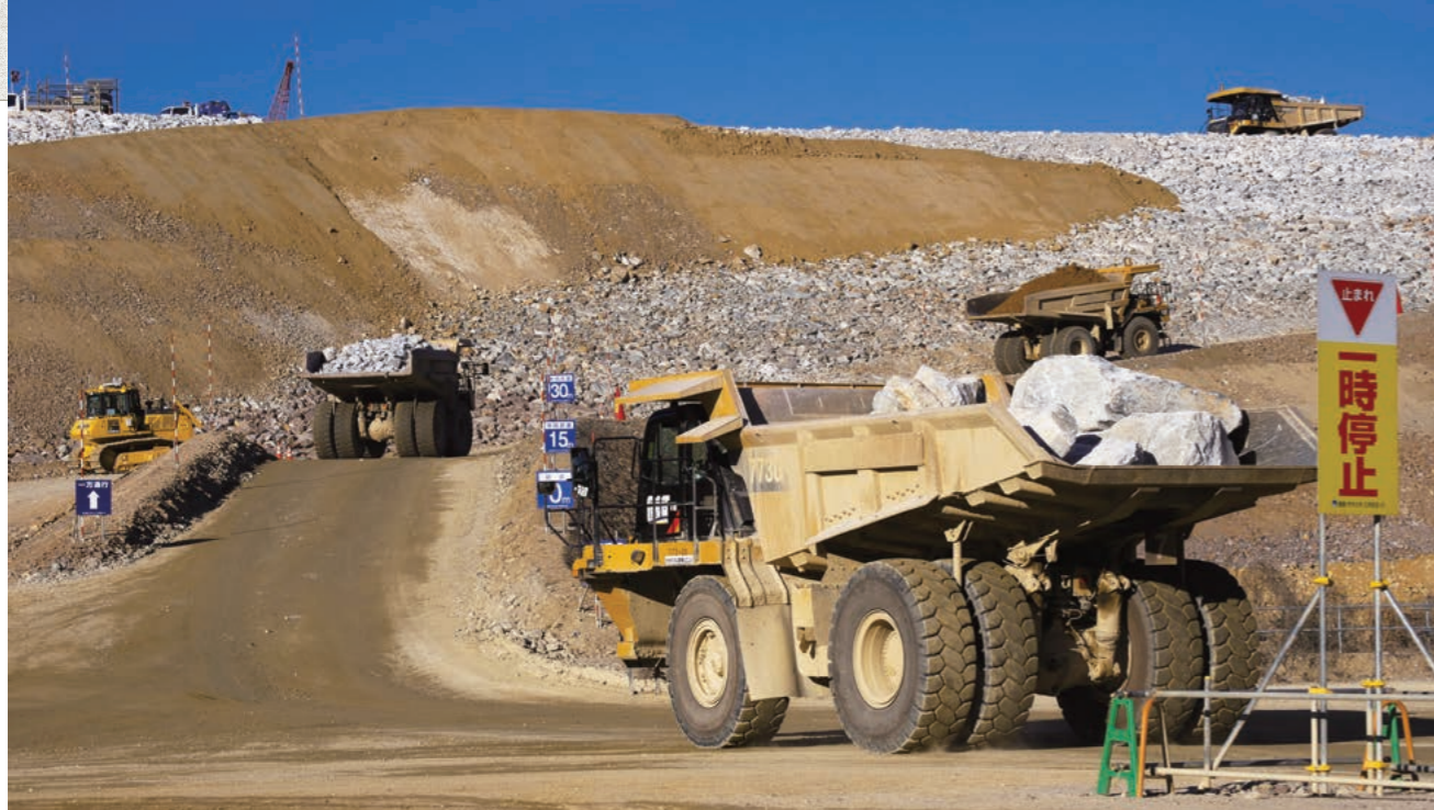
GPSを搭載した55t積級の重ダンプが現場内を整然と走り回る。土砂の搬入ポイント、土量などをリアルタイムで把握できる。ダンプ運行管理システムにより施工性、安全性が格段に向上した。
