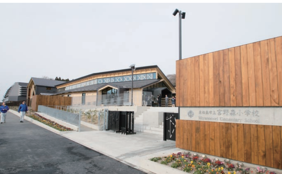
2017年1月、野蒜北部の集団移転地内に完成した「宮野森小学校」。1年生から仮設のプレハブ校舎で学んできた小学生が新校舎での思い出を作れるように、急ピッチで建設が進められた。
