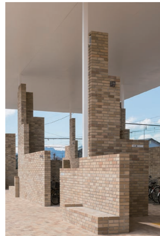
鉄骨フレームと煉瓦による鉄骨煉瓦積造。
