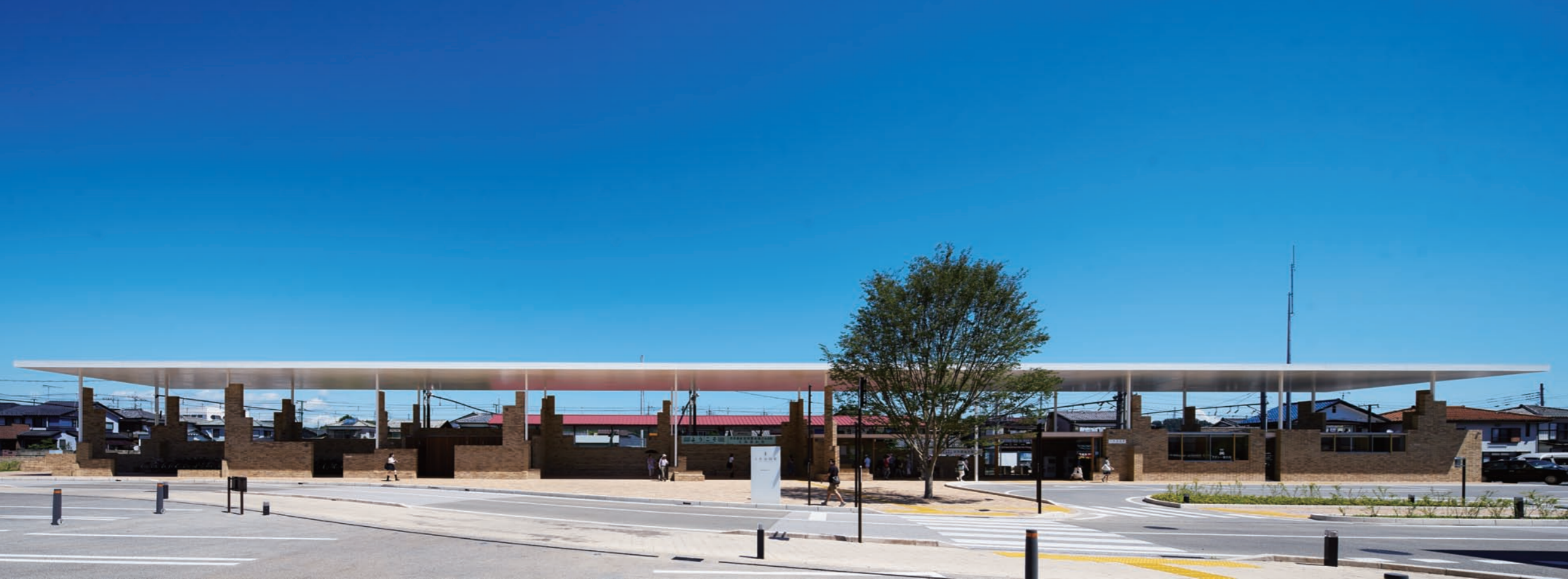
南側外観。東南方向より見る。
