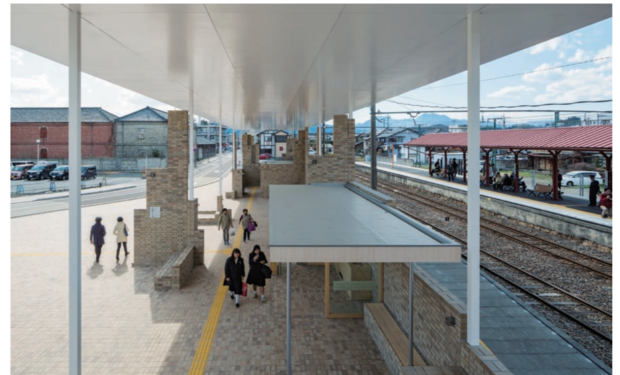
長さ89m、高さ6.9mの大屋根に覆われた空間、交流スペース。右手前の小型屋根の下にインフォメーションスペース。駅舎の前面に広場。
