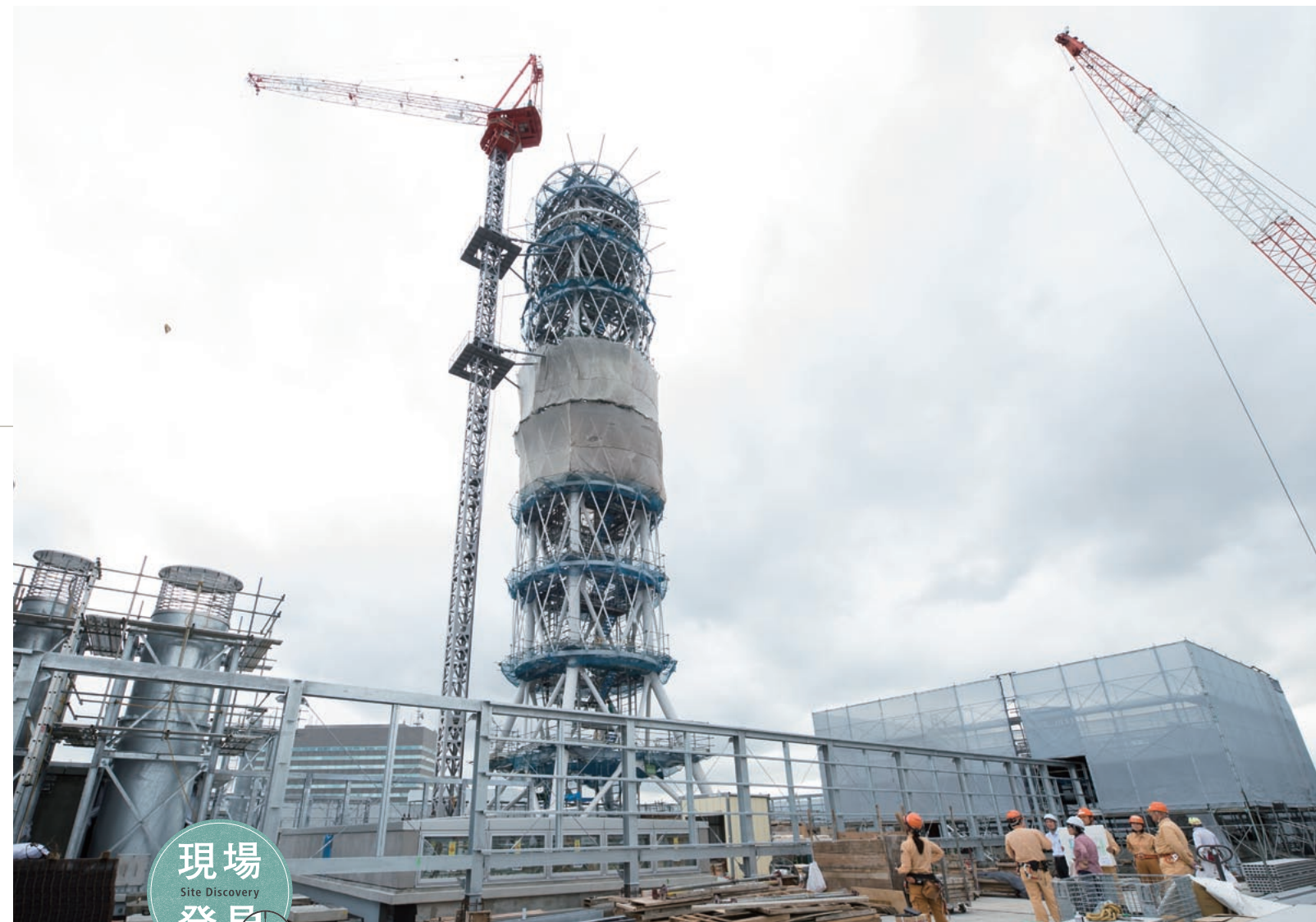
放送局のシンボルともいえる鉄塔は高さ60m。専用のクレーンで組み上げられた。建物の高さ40mを合わせると地上から先端まで約100m。別途各種のアンテナが取り付けられる。
