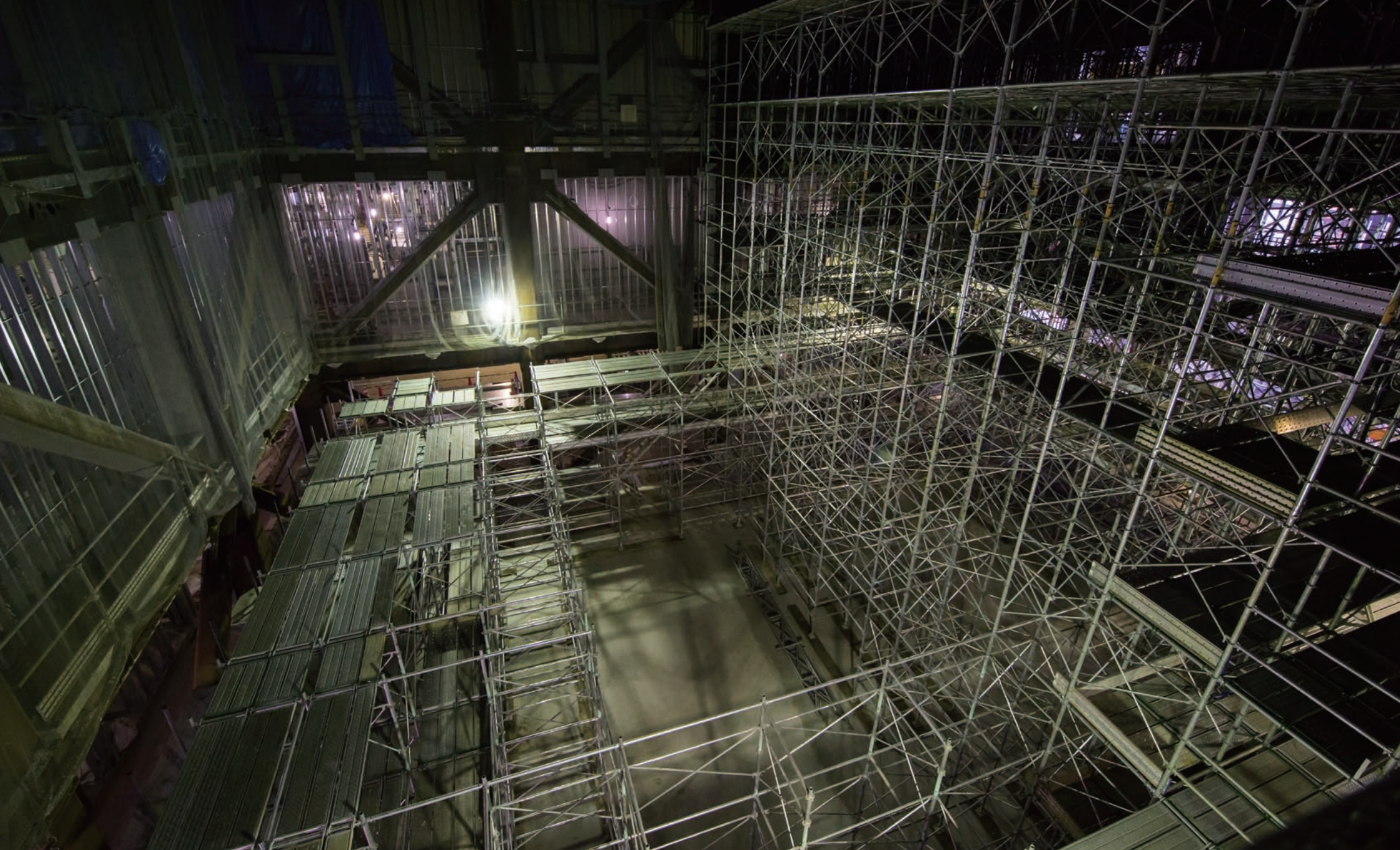
テレビ用の最大のスタジオ。1階～3階の3層吹き抜けで、階高は16m。半分足場を組んだ状況。右側は天井付近まで組み終わり、その上で天井から床へ向かって、遮音性能をもつ二重の空間をつくっていく。
