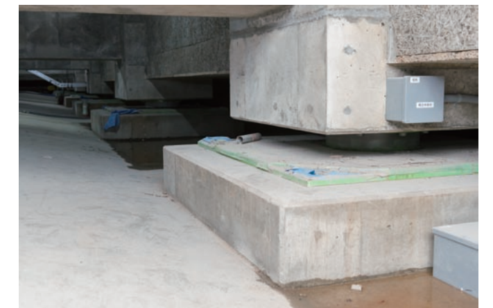
地下1階の下部に設置された積層ゴムアイソレーター。オイルダンパーを含め、5種類の装置が69基設置されている。オイルダンパー以外は押圧充填工法で施工された。
