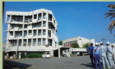
2015.4.19 宇土市役所庁舎解体方法の調査
