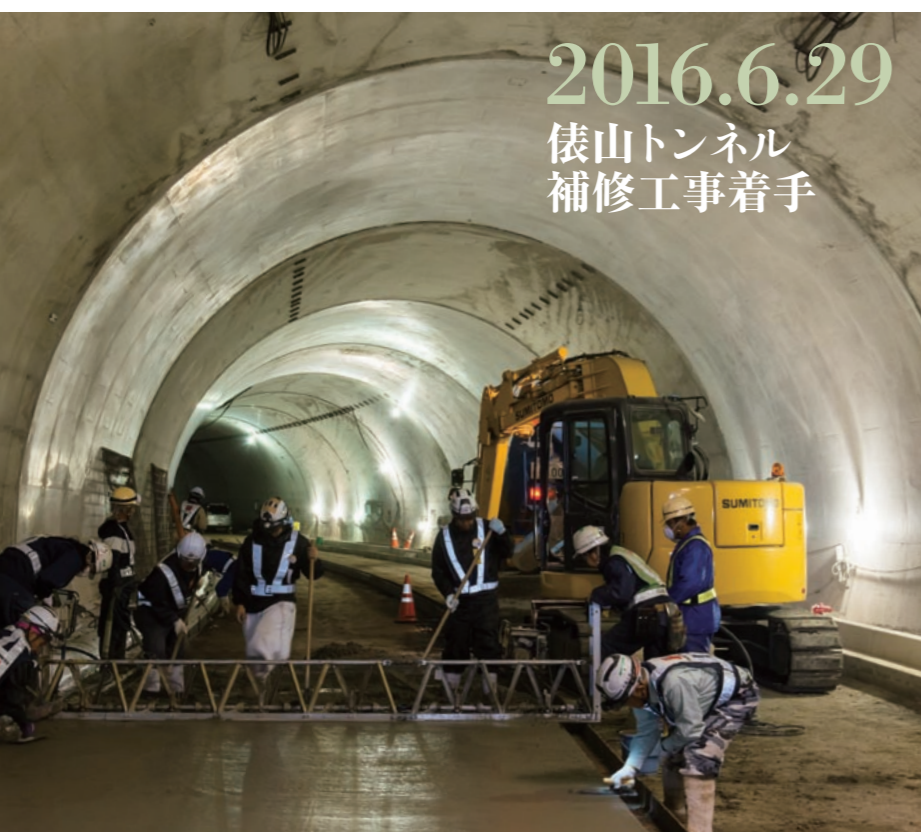
俵山トンネルでは2016年内の完了を目標とし、補修工事がはじめられた。日本各地から資機材や人材が集められ、24時間体制で工事が進む。トンネルを掘削するドリルジャンボや覆工コンクリートを施工するセントルなどの機材も用意。不測の事態にも対応できるよう万全の体制を構築している。
