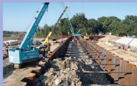
2015.9.22 二重締切中詰め状況
