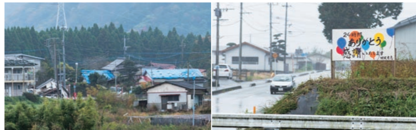
右/ 俵山トンネル補修工事現場付近の道路には村民有志のメッセージが掲げられている。地域からの応援が工事関係者の士気を高めていた。 左/ 南阿蘇村では発災から半年以上が経過しても、被災した家屋はブルーシートで簡易に養生され、復旧を待っている。
