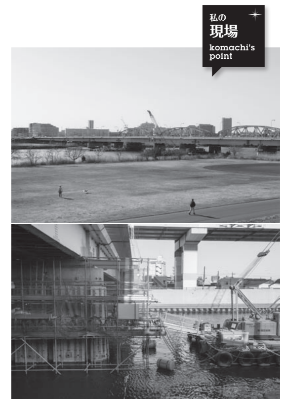
上/震災時の避難路や物資の輸送機能、復旧活動を支える道路機能の確保に向けて、橋梁の長寿命化と耐震補強を行っている。 下/掘切橋は荒川と綾瀬川を跨いでおり、濁水期にあたる11～5月までの7カ月間で両河川部の工事を進めなければならない。
