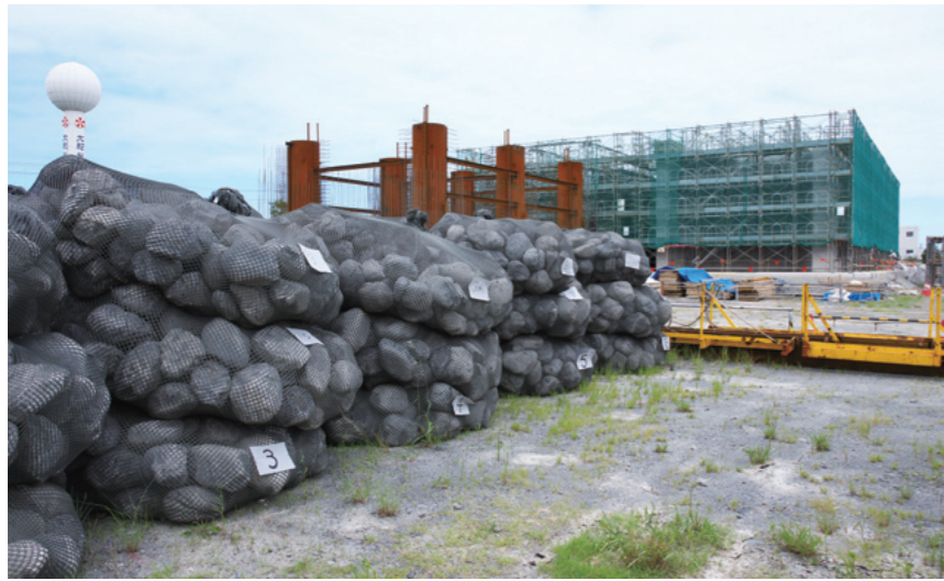
上／見学会に参加した子供たちが玉石にイラストやメッセージを書いてくれた。地元の思いを託された玉石が離岸堤の足元をがっちり固めている。(提供：東洋建設(株)) 左／鋼管杭を打設した海底部には袋詰にした玉石を設置、杭を固定する。
