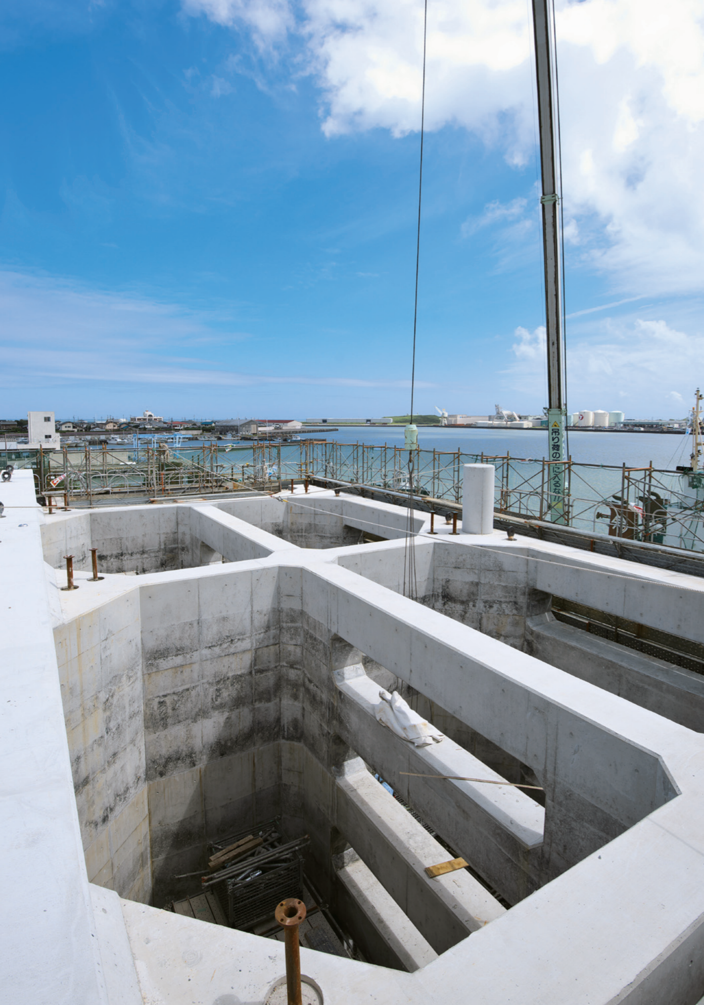
製作ヤード内で順次7箇の「バリアウインド」を製作。これを据付場所に曳航、据え付けて約150mの離岸堤を築造する。その高さは8.2m。周辺からは何の建物をつくっているんだろうと言われることもある。
