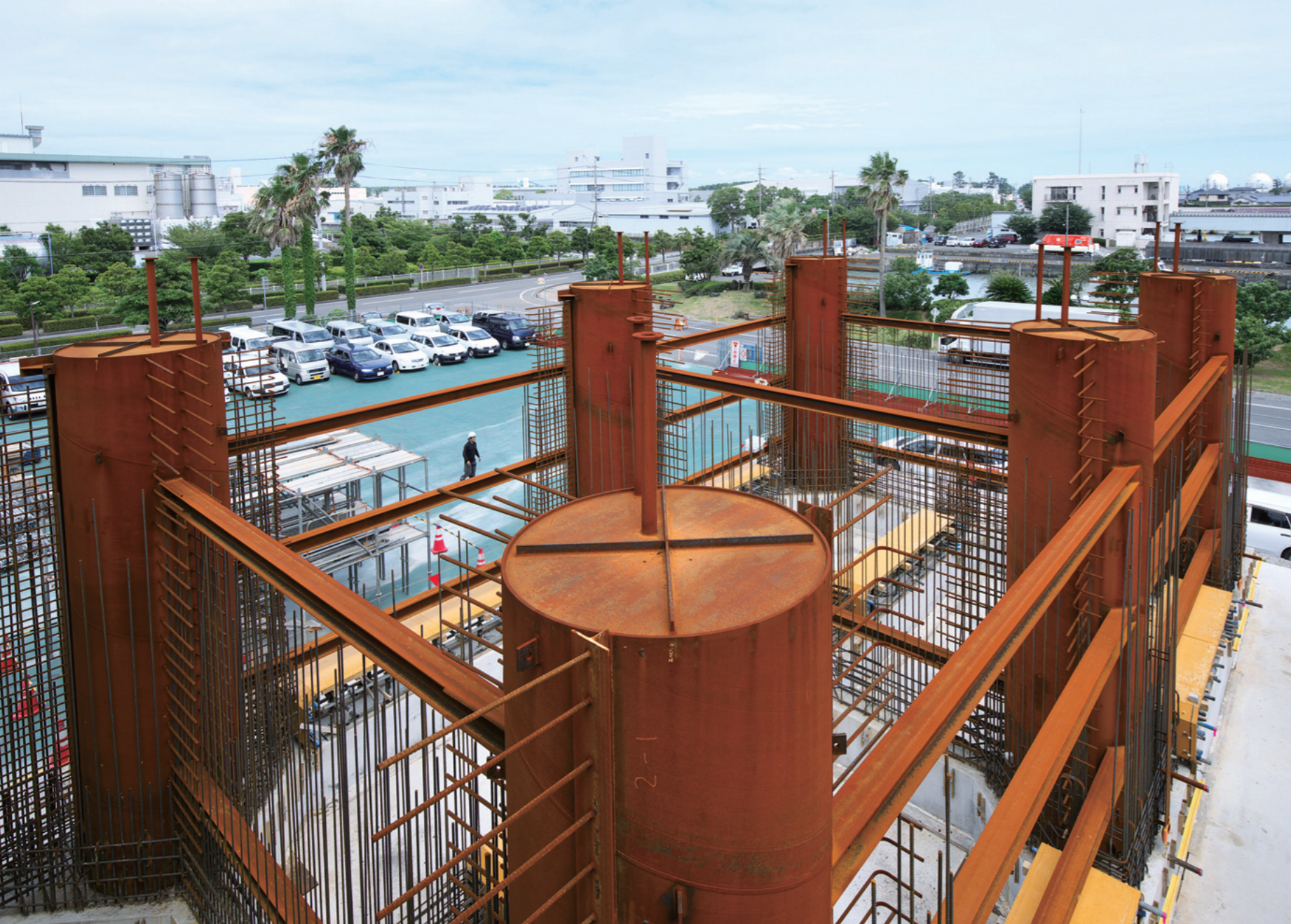
バリアウイントの函体製作は6本の鞘管組立てとスタッド鉄筋溶接から始まる。この鞘管と海底に打ち込んだ鋼管杭は、刀の鞘と刀身にたとえられる。鞘管と鋼管杭の間隔、寸法が合わなければ据付に支障をきたすため、函体の製作には高い精度が求められる。
