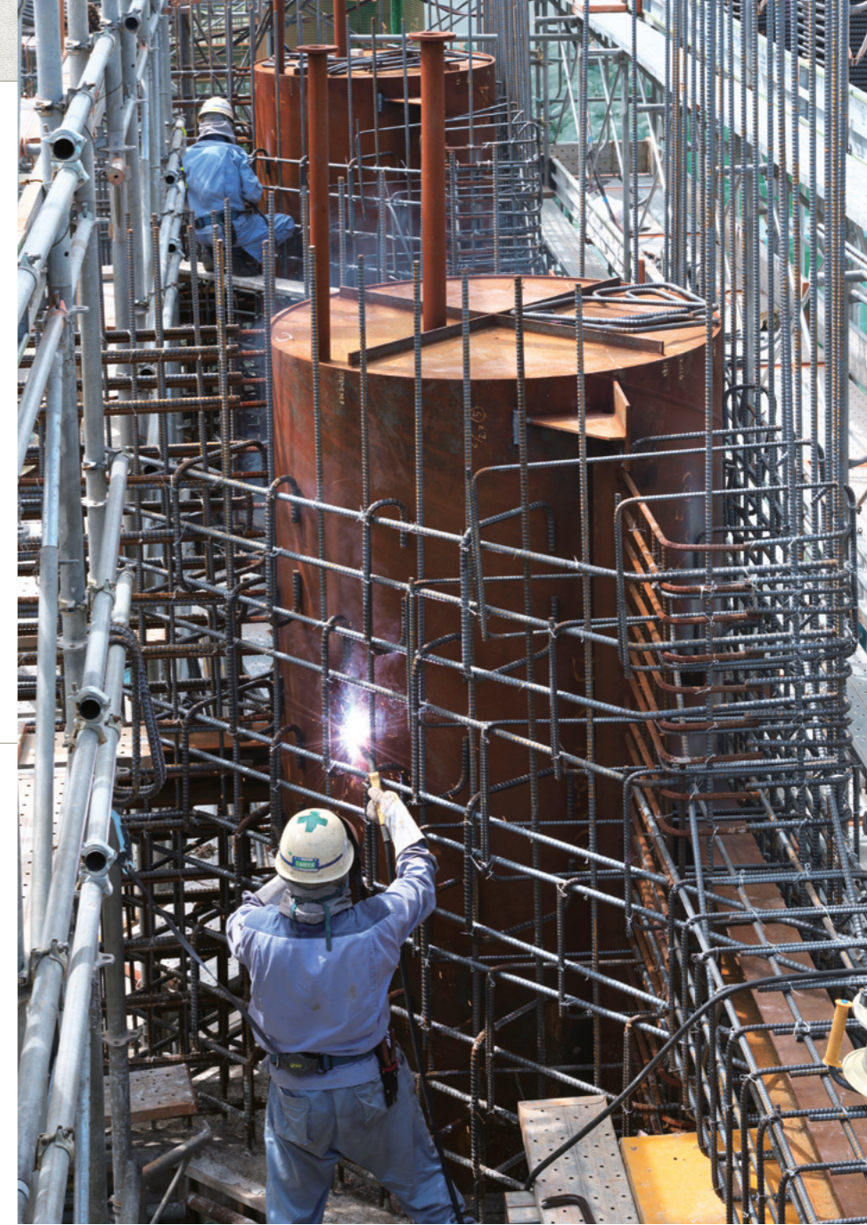
コンクリートの打設を控え着々と鉄筋工事が進む。鞘管の上部の2本の管は、管下から注入したグラウトに押し出される余水を排出するもの。函体には据付を想定した様々な装備が施されている。
