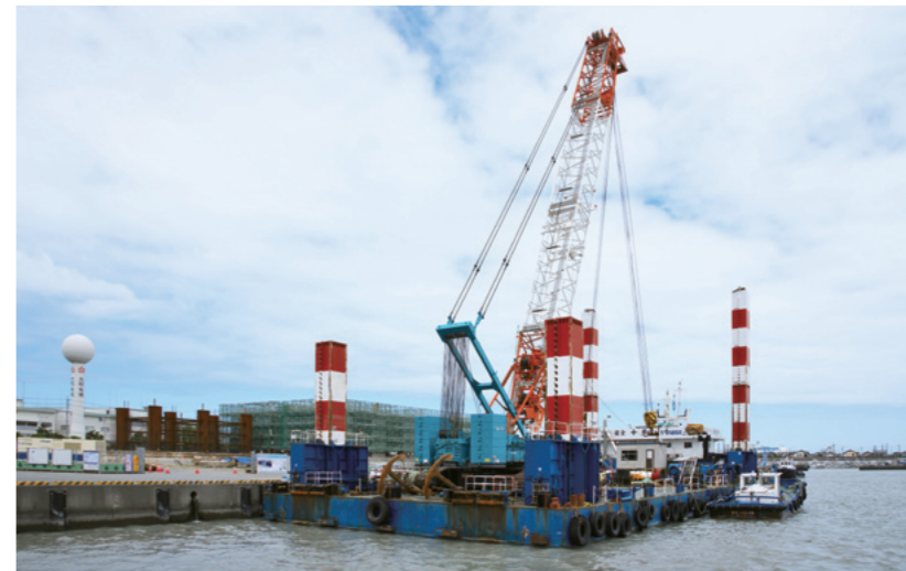
鋼管杭を打設する設備を搭載した作業船。4本のスパッド（鋼製の杭）を海底に打ち込んだあと、その支持力で海面から船体を浮かせる。波の影響を受けずに鋼管杭を打設することができる。
