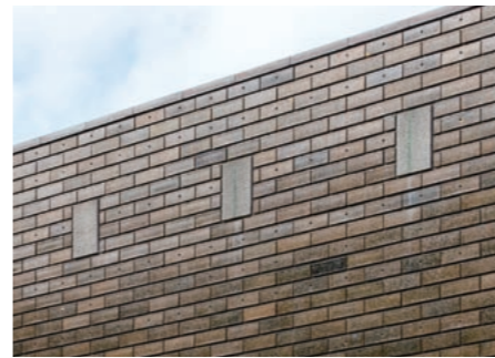
右／企画展示室。3つの企画展示室があり、一つは天井高を高く設定されている。ポストテンション梁を採用することで途中に柱の無い大きな空間を生み出している。 上／緊張させた梁端部の所在を意匠としても表している。
