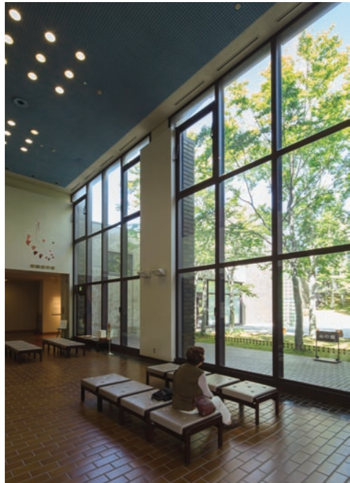
常設展示室ロビー。高さのある窓から「山の庭」の風景が目に入ってくる。新潟の長い冬のくもり空を晴らすように、天井はブルーの色に塗装されているという。開口部のサッシはコールテン鋼（耐候性鋼）の枠にペアガラスを入れて製作。枠とガラスの接触部分を断熱し、結露を抑えている。
