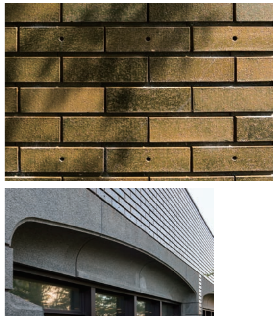
上/打ち込みタイトルの壁面。1枚1枚の表情が異なり、同じものがない陶の作品のようだ。孔あきタイルはコンクリート型枠のセパレーターを通したタイル。一部はデザイン統一のために使用。下/開口部を壁面より後退させ、上部(まぐさ)に庇の機能を持たせた。洗い出し仕上げの擬石プレキャストコンクリート。打ち込みタイトルの躯体にはめ込まれている。
