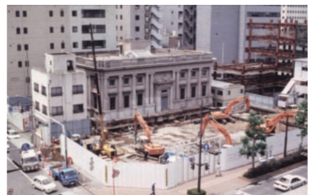
曳家の状況。敷地の前面の保存建物が建っている部分をA工区、奥をB工区とし、平成4年5月にAからBへ往路の曳家を実施された。上/A工区でジャッキアップされ、B工区へ向かう。下/24.5m移動し、B工区に仮置きされた状況。(提供：岡部則之計画工房)
