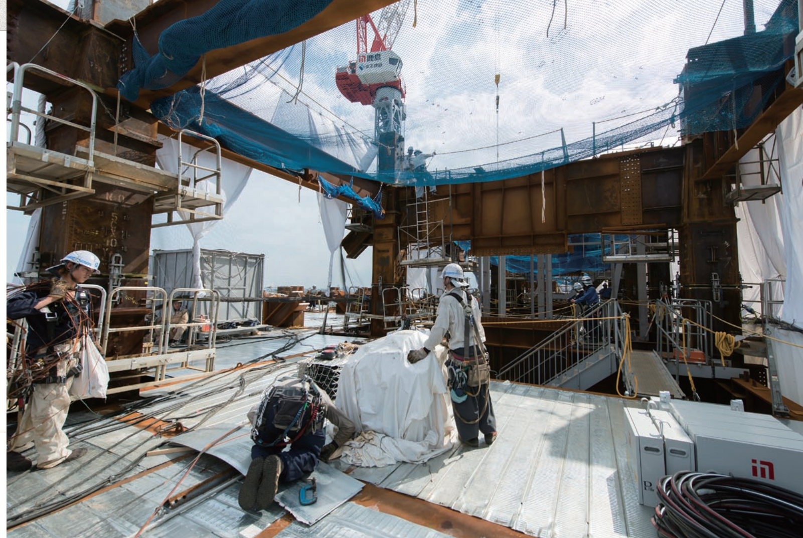
現在、鉄骨建方作業が進む9階部分。
