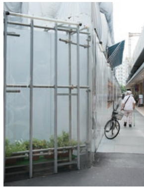
仮囲いの一角を活用して小さな花壇をつくった。警備員や作業員が交代で水やりをしている。苗の仕入れは女性職員の川上さんが「園芸部」として担当。「ささやかですが地域貢献になればと大切に育てています」。
