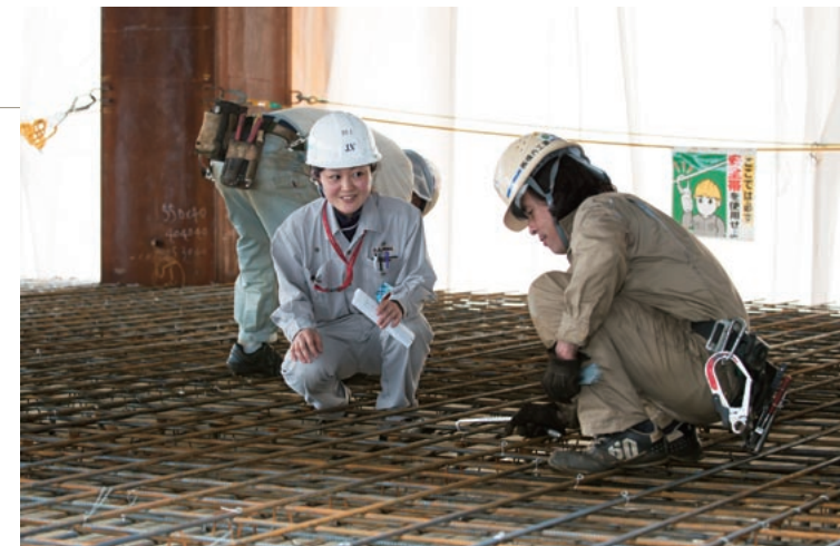
上/常に一步先の工程を考えて綿密な相談、打合せを繰り返す。 下/図面担当だが、今後の工程では現場に出る機会も増えてくる。
