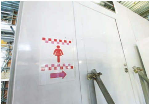
現場には女性専用の水洗トイレ、更衣室も完備している。場内の通路には植栽を施した。こうした試みも女性が働きやすい職場づくりに一役買っている。
