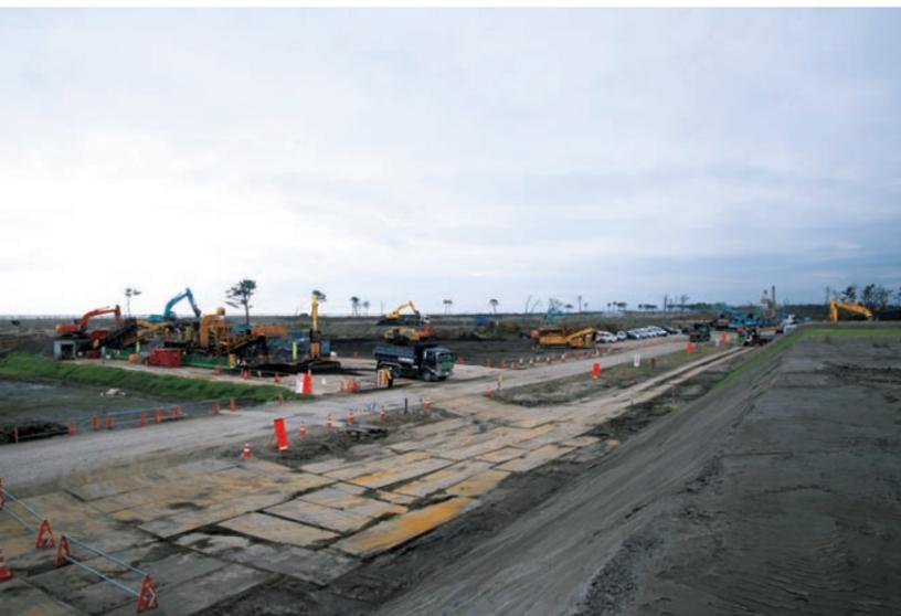
堆積土砂の含水比は30~40%。これを天日乾燥して20%まで落としてふるい機にかける。出来上がった客土材は写真手前のように5,000㎡の盛土に整形し出来高検測される。
