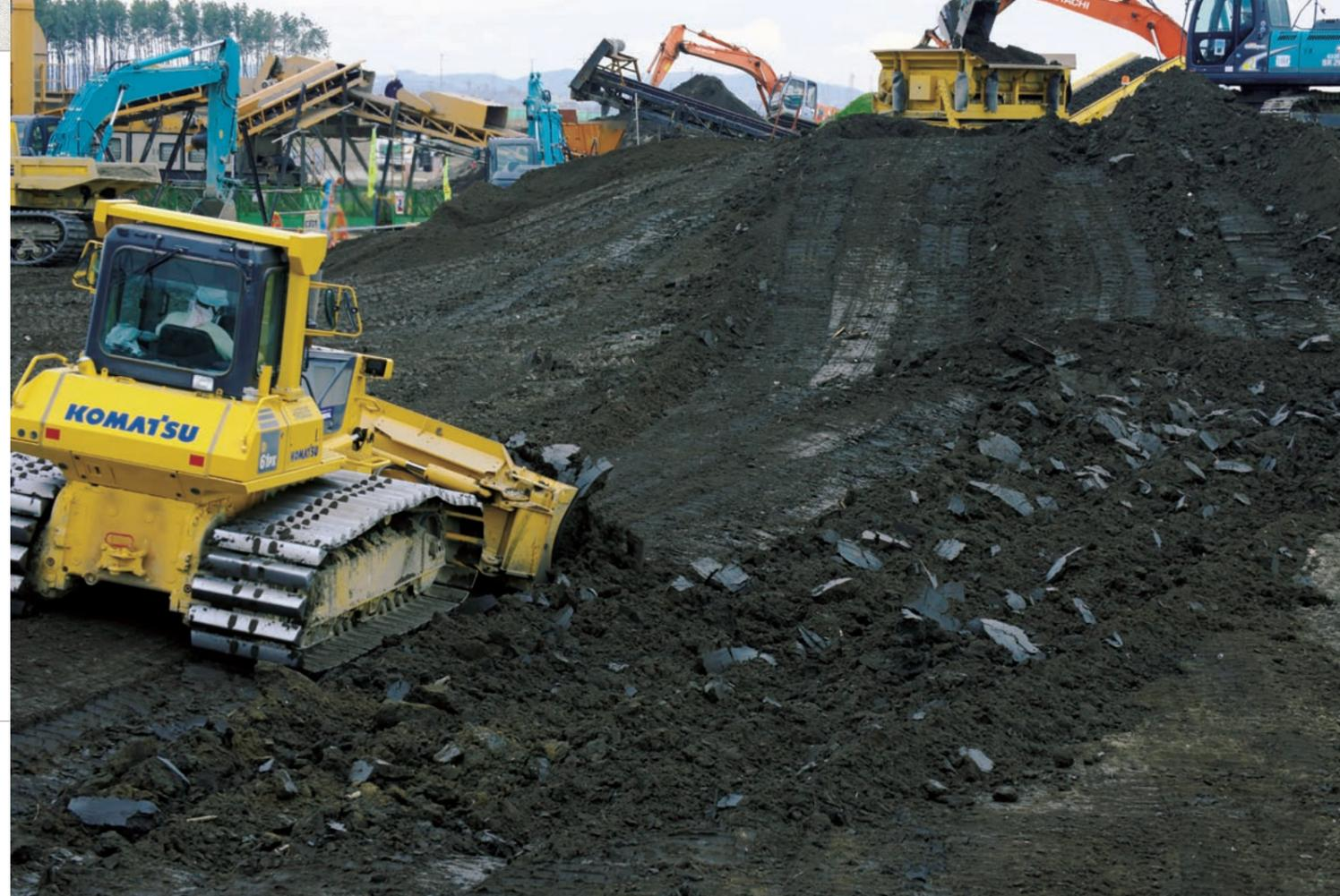
小山のような堆積土砂を少しずつ切り崩し、ふるい機のホッパーに投入、農地用の客土材を造成する。土砂に何が混入しているかは振るいにかけてみないとわからない。慎重さとスピード感が求められる現場だ。
