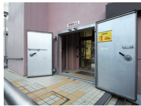
下水道事業団（蒲生分室）がある管理棟。地盤が沈下（約六〇センチ）したため、浸水対策として一階の開口部を閉塞するとともに、出入り口には防水扉を設置し、二〇一三年三月末に電気系統や汚泥系の処理機能が完全復活した。
