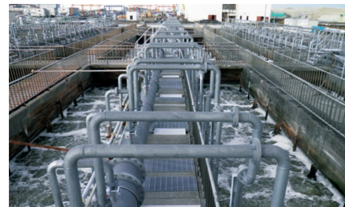
稼働中の中級処理施設。昨年1月からは水槽内に微生物が付着した接触材を充填する接触酸化法を採用し、段階的に水質向上を図っている。（提供：日本下水道事業団）
