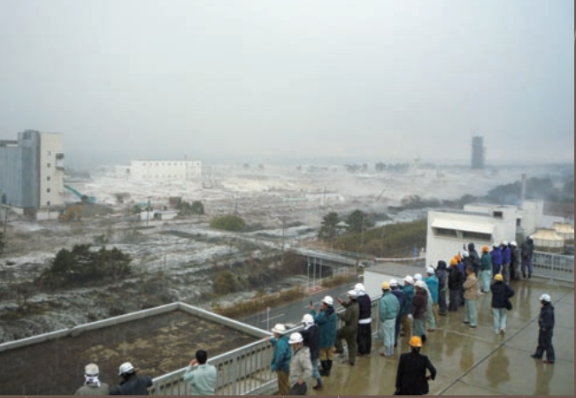
敷地全体を覆う津波。震災直後は電気、機械が使用不能だったため、下水は最初沈殿池で沈殿処理した後、塩素による滅菌消毒を施し太平洋に放流された。(提供：仙台市南蒲生浄化センター)
