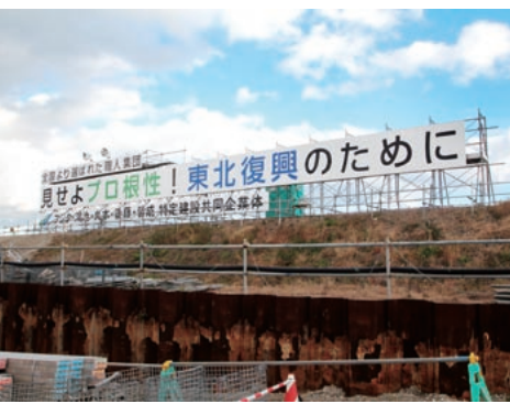
「早期から調整を行った結果、北は北海道から南は沖縄まで、全国から四〇〇名を超える作業員が集結してくれた（大西所長）。現場が一体となって工事にまい進する。
