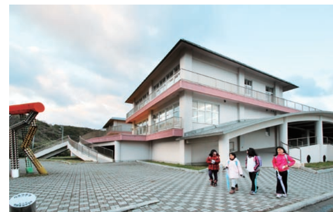
ピロティ構造の青苗小学校。2、3階を教室とし、1階部分の空間に津波を流下させてその被害を最小限に抑える高床式だ。
