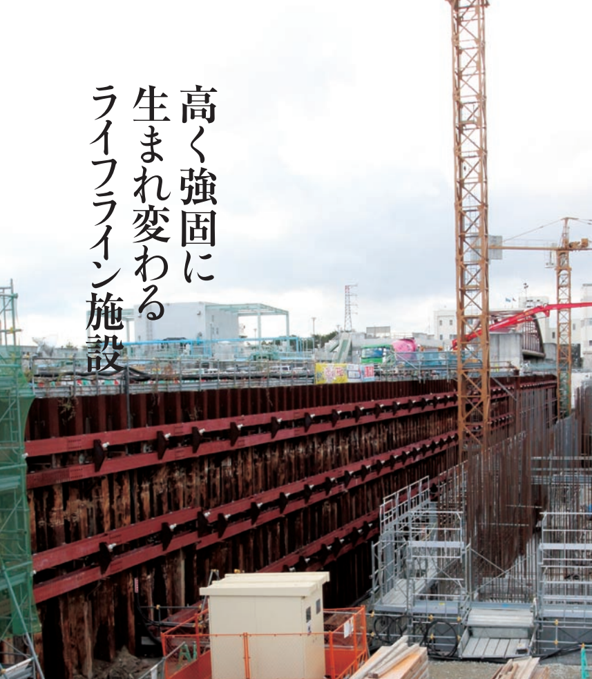
左/南面のアースアンカー工法による土留鋼矢板。東西両面については、地中埋設物を避けて外側に打設し、当初計画（アースアンカー工法）からアイランド工法に変更するとともに、ウォータージェットを採用し、工場に連結した24mの長尺矢板を一挙に打ち込むことで大幅に工期の短縮を図った。右上/場内に設けられた鉄筋加工専用ヤード。右下/巨大な水槽の重さに耐えられるよう、土壌にセメントミルクを混ぜ込んで固化させるパワーブレンダー工法にて地盤改良を行った。
