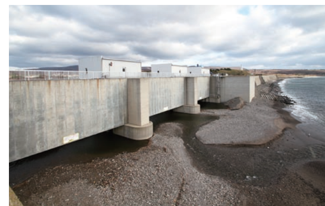
津波が河川を遡上し流域に被害をもたらした教訓から河川に水門を設けた。震度4以上の地震を検知すると1分間の非常放送の後、自動的にゲートが降下する。
