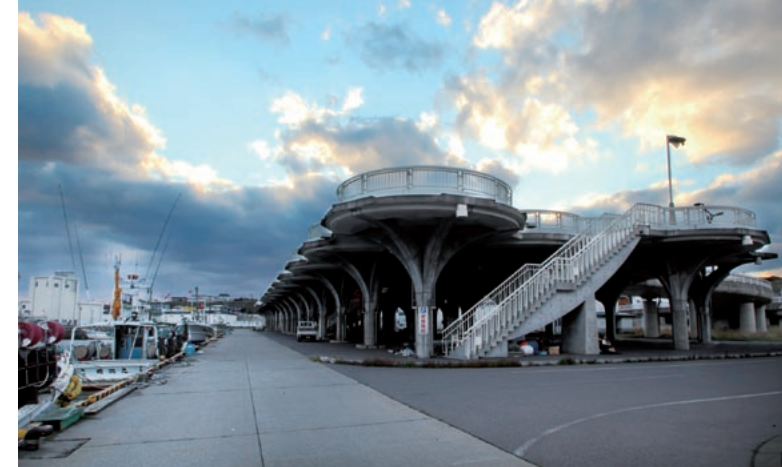
青苗の漁港に設置された人工地盤の高さは海面から約8m。津波の際、漁業者は岸壁からこの人工地盤へ上がり、さらに高台へ避難できる構造だ。
