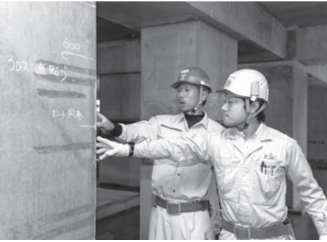
左/柱表面の仕上がりをチェックする。「2mmと言われれば2mmで、1cmと言われれば1cmで塗れます。これはもう感覚としが言いようがないです」 右/狭いところ、広いところ、隣の建物との隙間…塗る場所によって無数の鏝を使い分ける。
