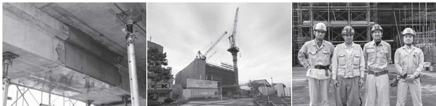
左/梁下の補修工事。現場でつくった梁と現場でつくる梁をつなぐ部分で、つなぎ目をうまくならして目立たなくするのも左官工の技術だ。中/完成すると山手線内で最も高いマンションになる西富久地区第一種市街地再開発事業。これから躯体工事が本格化すれば、左官工である山口の活躍の場も増えていく。 右/左から、戸田建設・芦田作業所長、浪花組・富永職長、山口、戸田建設・瑞慶山建築係員。山口はまだこの現場に入って間もないが、いずれは職長に、と期待されている。
