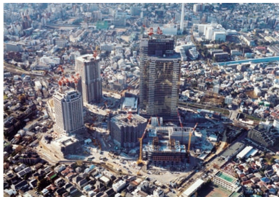
上は1992年5月。下は1993年12月の施工状況。掘削と地下工事がいかに膨大だったかがうかがえる。(撮影：SS東京 提供：Fix)
