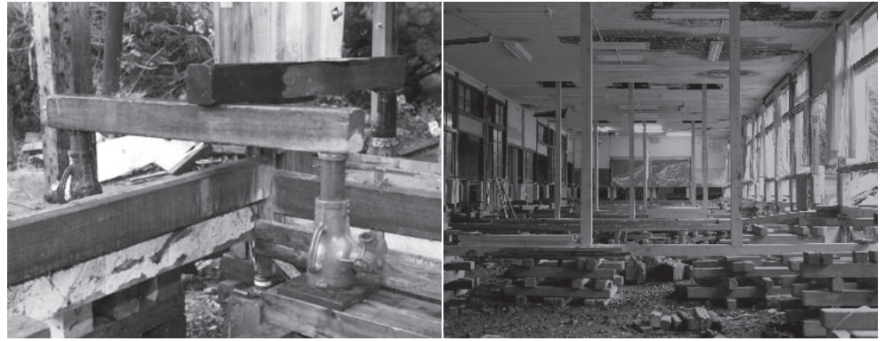
左／ジャッキにも目的に応じているいろんな種類がある。ジャーナルジャッキの15t用は重量20kg以上。 右／旧桑浜小学校の現場にて。教室の壁を取り払い、新たに柱を立てた。当初予定していなかった追加工事が発生しがちなのも曳家工事の難しさの一つ。
