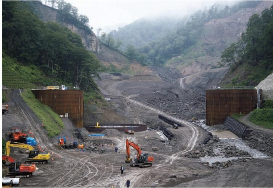
最終的には迫川両岸100mにわたって4基の鋼製セルを設け砂防堰堤を構築する。右岸で3基目の構築が始まっていた。
