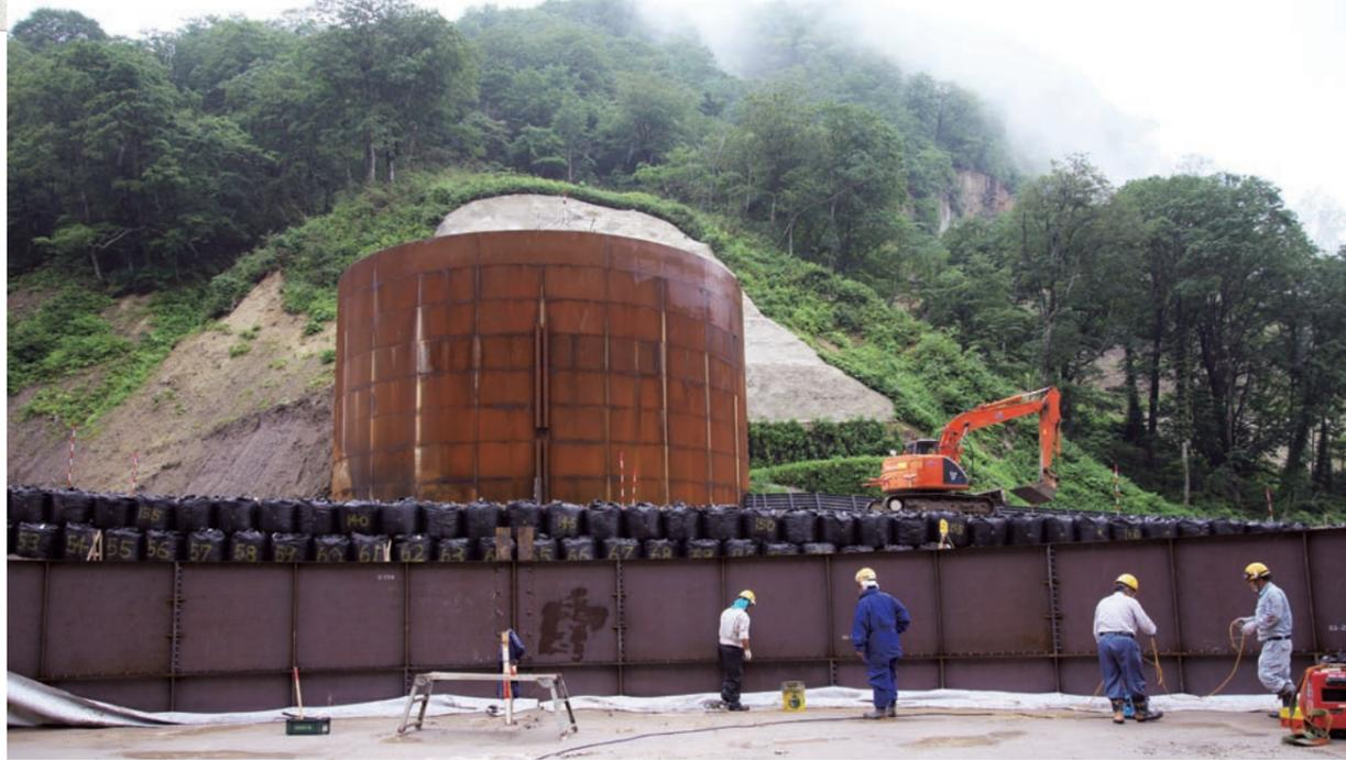
堰堤の内側でINSEM工法によるソイルセメントの中詰作業がていねいに施されていく。中央の2基の鋼製セルは14.5mの高さまで部材を組み上げて構築する。
