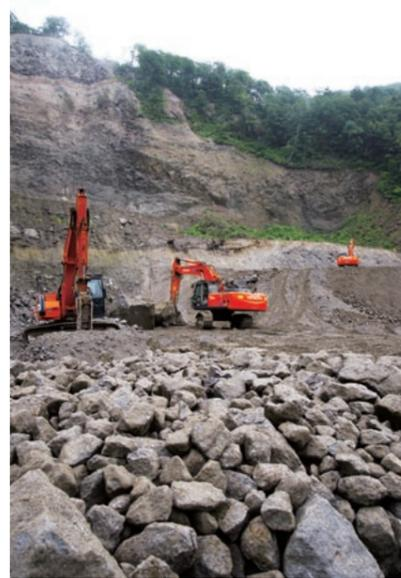
崩落した土砂、岩を大きさごとに選別し、土質改良機に搬送する。ダム建設でいう原石山だ。
