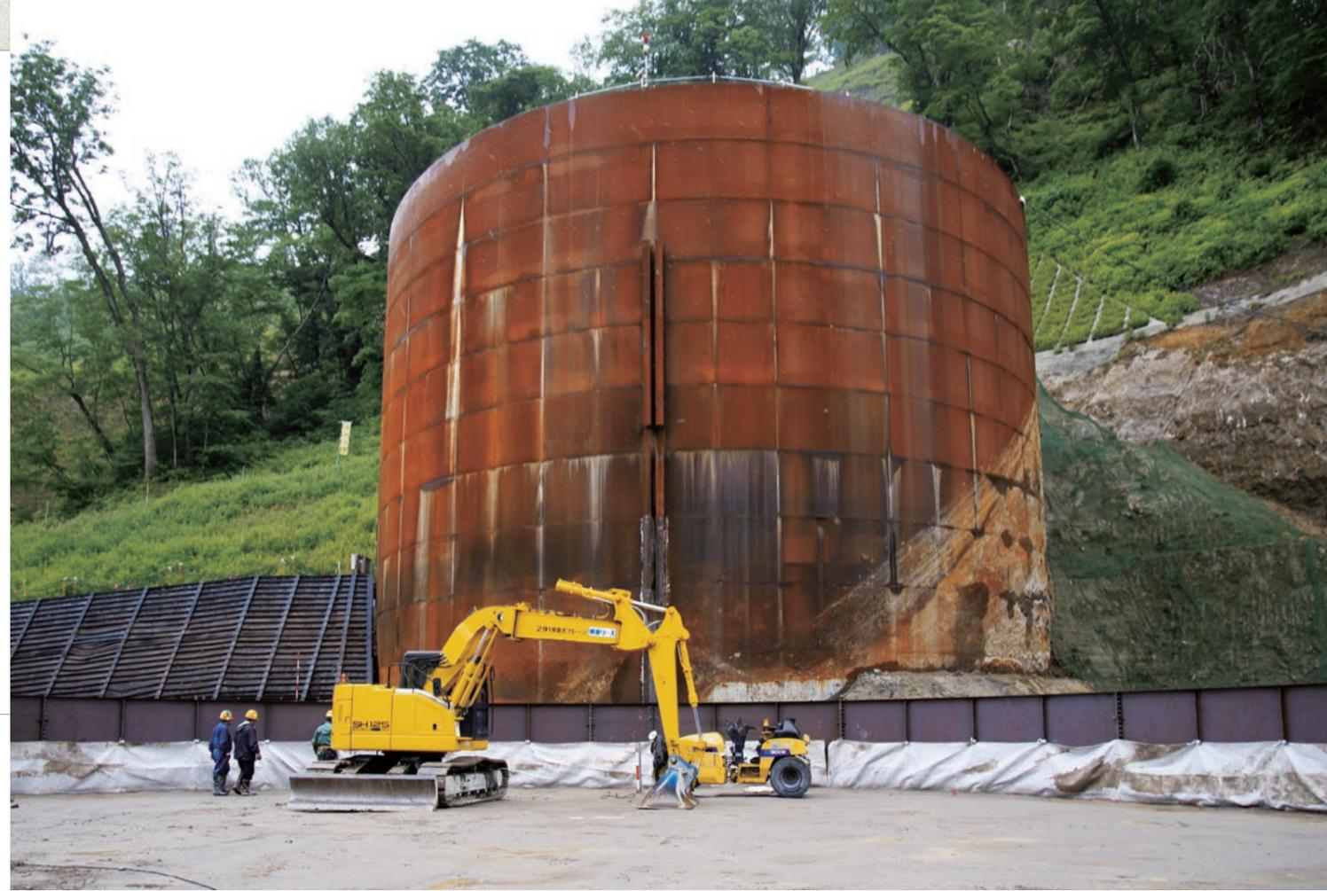
既設の鋼製セル堰堤に接して3基目の堰堤構築が進む。栗駒山は日本二百名山のひとつに挙げられる秀峰だが5年前、その美しい山麓の一部が崩落、土石流となって甚大な被害をもたらした。堰堤は下流の人々の生命と財産を守る重要なインフラとなる。
