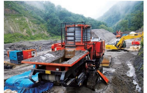
生コン車での資材搬入が困難なため、コンパクトな「プラント」が現場内に設置された。発生土砂はこの自走式土質改良機によりセメントと均等に攪拌混合され、基礎造成、構造物構築の資材として有効活用される。
