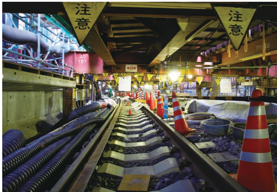
左に見えるのが代官山駅の新しいホーム。現ホームを仮受けしている。微妙なカーブを描くホームにあわせ、内側に傾斜をつけて軌道を敷設した。
