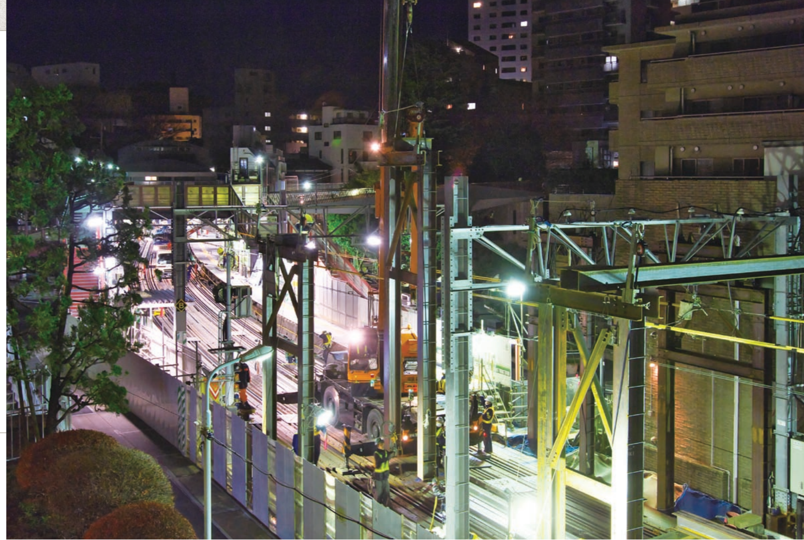
現場では門型の「門構(※)」の設置が進む。現在東横線が走る線路を支える工事桁は、切替え当夜にこの門構によって持ち上げる(扛上する)ように外される。その直下には真新しい軌道が待っている。
