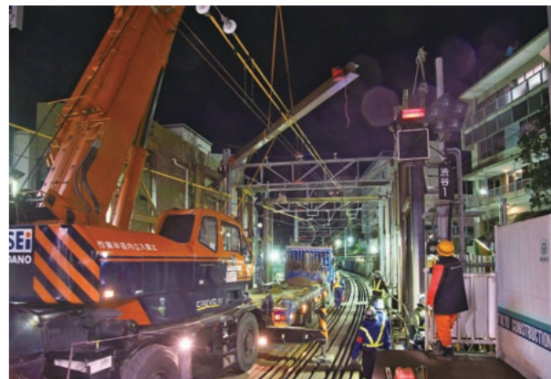
この門構の設置は終電後の深夜にスタート。限られた時間内での作業にミスは許されない。
