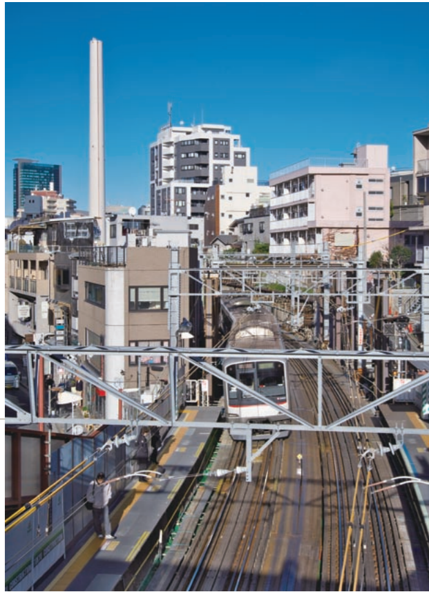
跨線人道橋から起点方渋谷方面を望む。密集するビルの間を縫うように東横線が走る。切替え工事のために仮線路を敷設する空間的な余裕は無い。
