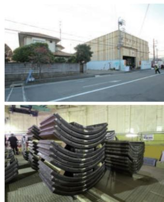
市街地に隣接する立坑は防音ハウスで覆い施工音を遮断(上)。セグメントなどの資材は防音ハウス内部の二階にストックし省スペースを図った(下)。
