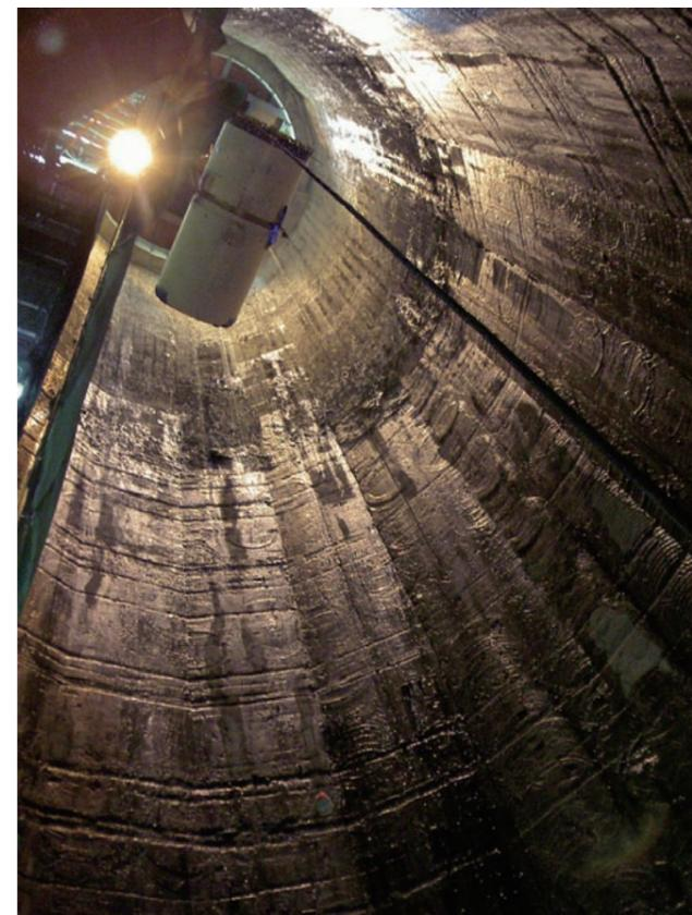
連壁工法により施工された立坑は「鉛筆」のように細長い。強度を維持しつつ施工性を高めるため壁柱の割付けなどを変更。最先端の計測システムにより深さ70mという掘削深度で最大変位25mmという高精度を達成した。
