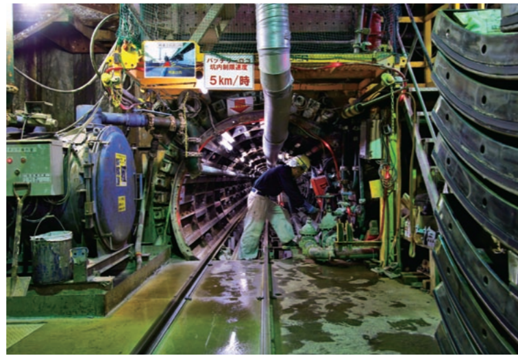
トンネルの入り口。内径は2mだが、空気や水、泥水の送排配管や、軌条などがあり、実寸より狭く感じる。
