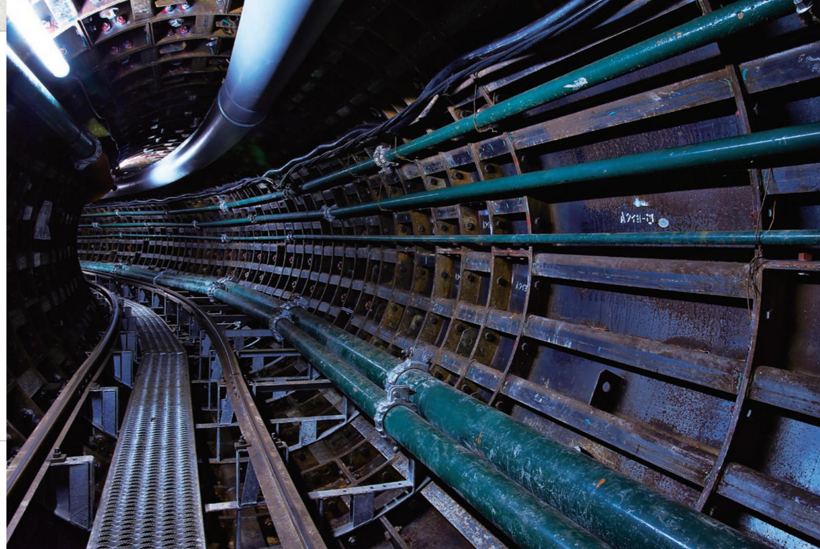
急曲線部では、幅の狭い補強用セグメントを施工し土圧に耐える。台車の軌条が乗る枕木の中央部を切り下げて歩行通路とした。
