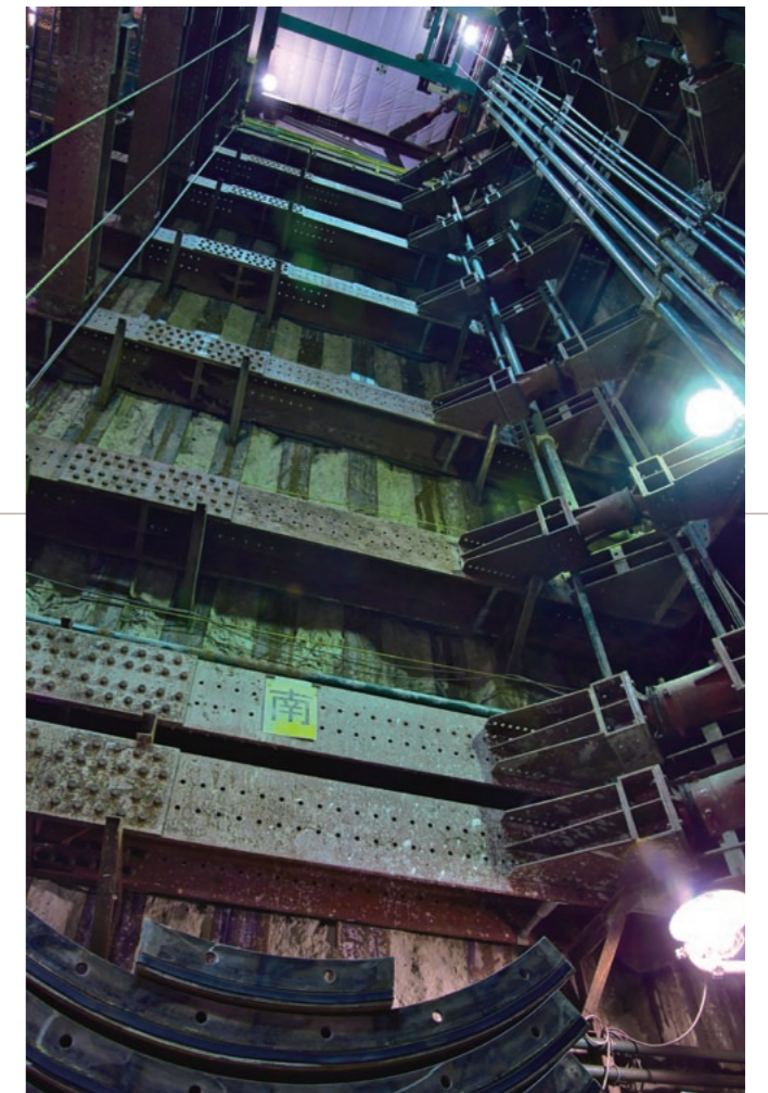
地下約30mの立坑底部から見上げると、ソイルセメントと鋼材で構築された「連続壁」の縞模様が一直線に伸びていた。
