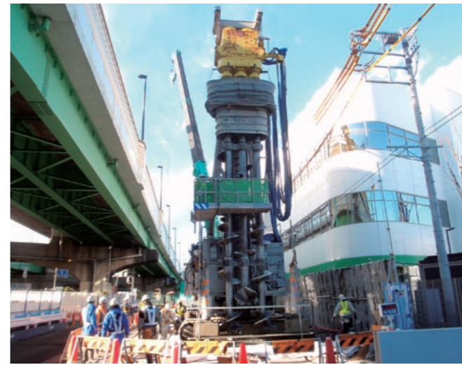
立坑の築造に使用した超小旋回型SMW機。狭隘で空頭制限がある特殊な現場でも安定的な機動性を発揮する。(提供：㈱竹中土木)
