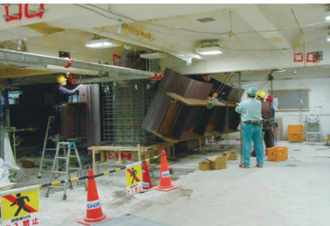
階高が低い場所での施工となり、ほとんどの工程が人力で進められた。(提供：清水建設株)
