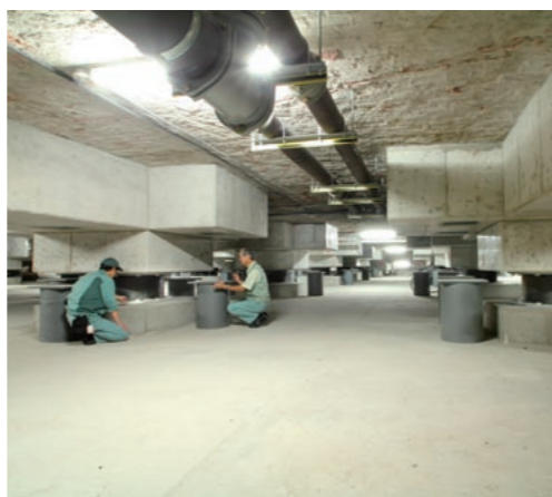
設置された免震装置は、鉛プラグ入り積層ゴム二五八カ所、弾性すべり支承五六カ所で合計三一四カ所に及ぶ。日常のメンテナンスは三越環境ビル管理の建物管理担当の手で行われる。
