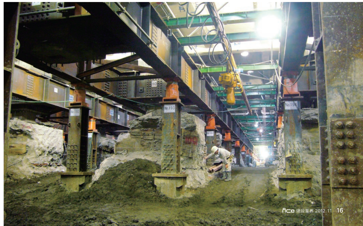
建物北側の基礎工事。既存の地下1階の床を解体後に基礎を掘削。深礎杭を打設し、建物を仮受けする柱を設置した。(提供：清水建設株)
