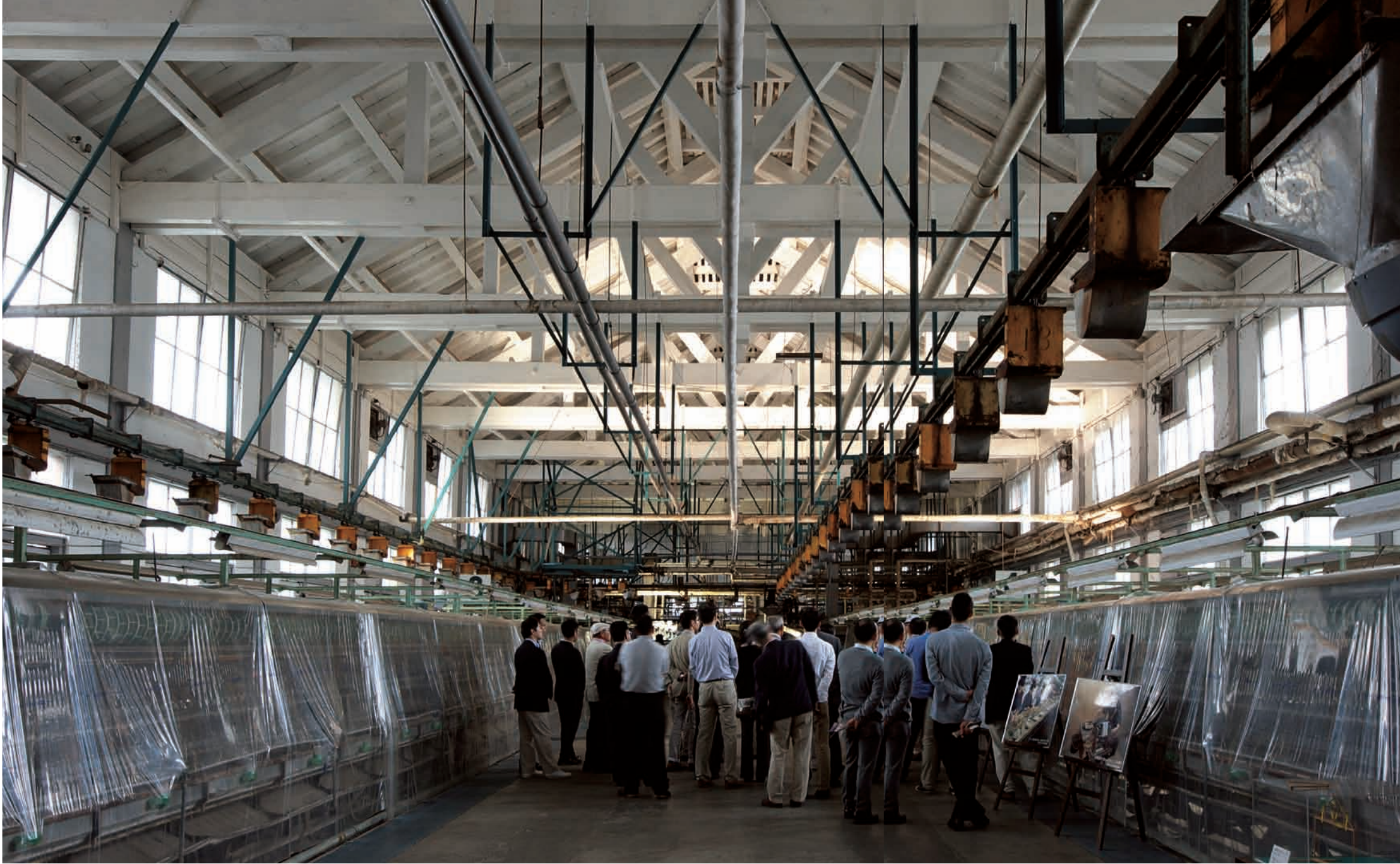
富岡製糸場繅糸工場の内部 ビニールシートの覆いをとると、表紙のような自動繅糸機が両側に整然と姿を表す。屋根を支える小屋組はトラス構造で、柱がひとつもない大きな内部空間をつくりあげている。
