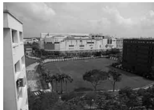
南側外観(工事着工前)
